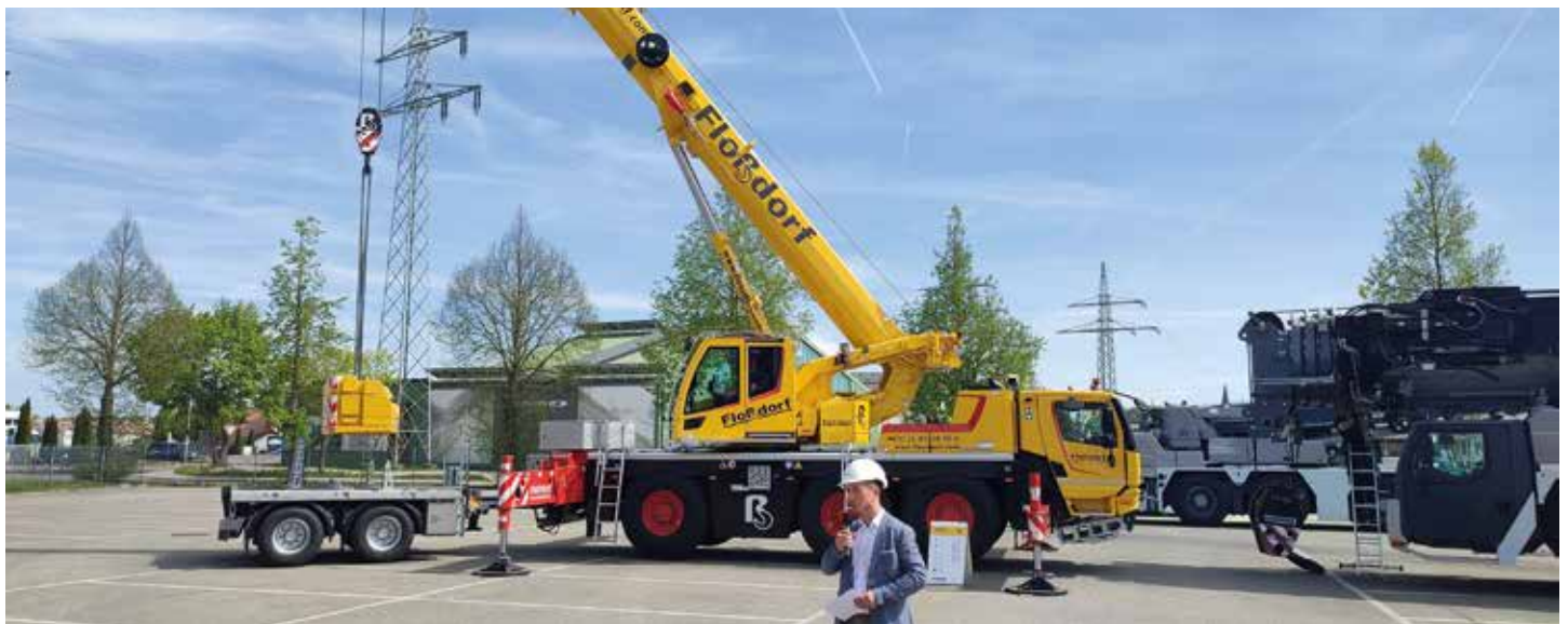
Der LTM 1055-3.3 mit Ballast-Anhänger ist dabei den eigenen Ballast zu montieren.
