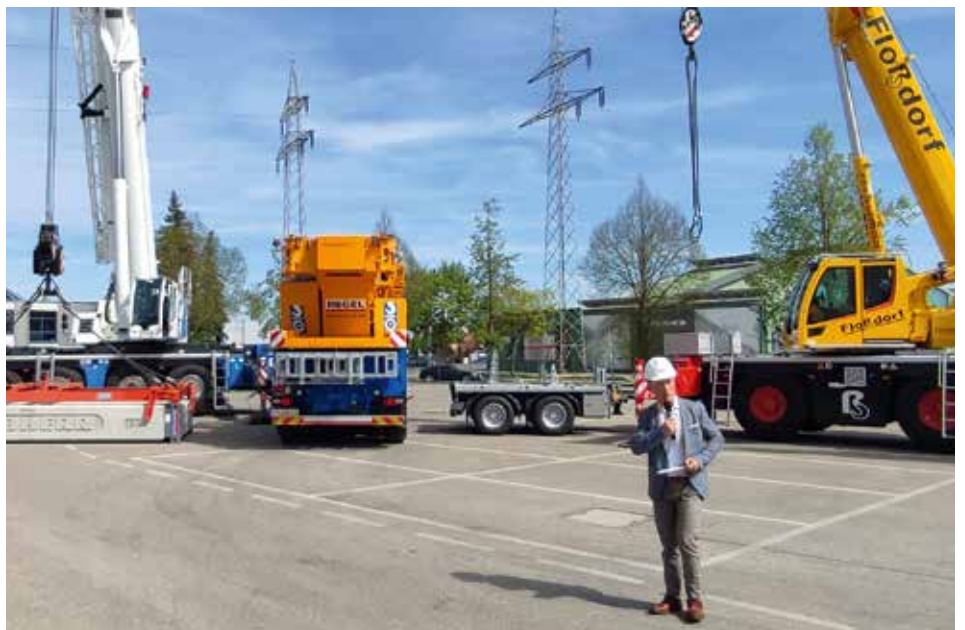
... Baustellen beim Rangieren immer beste Sicht auf das Geschehen.
