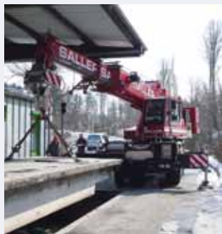
Bei dem Tandemhub musste AC 55 City seitlich versetzt mit einem äußerst flachen Auslegerwinkel die 43 t schweren Plattenwaagen anheben.
