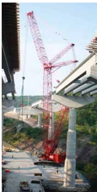
Manitowocs Raupenkran Model 18000 hilft bei der Sanierung einer Brücke.
