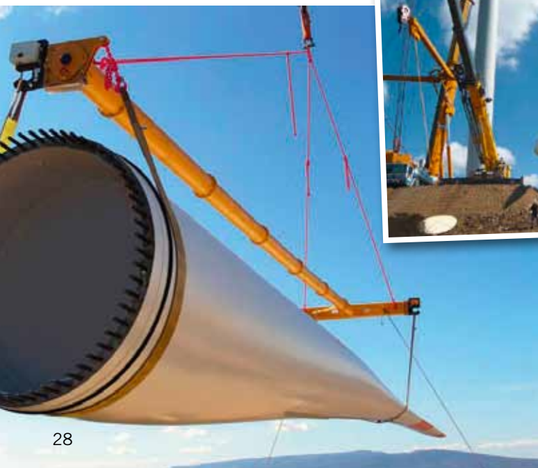
VarioBeam ... ... nennt Axzion die gemeinsam mit Nordex entwickelte Traverse zum „Aufstecken“ einzelner Rotorblätter auf die schon an die Gondel montierte Nabe. Dieses System bietet den Vorteil, dass noch bei recht hohen Windgeschwindigkeiten der Rotor montiert werden kann, während der Hub des am Boden vormontierten Rotorsterns mit Teleskopkränen nur bei einer Windgeschwindigkeit bis 6 m/s zulässig ist.
