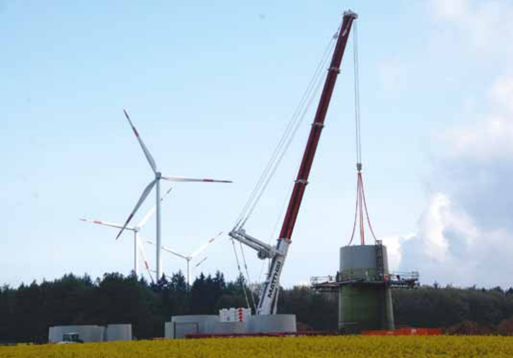
Mehr Hübe mehr Krane: Inzwischen kommen an einer WEA auch schon einmal mehr Krane als einer für die Montage und ein Hilfskran zum Einsatz. Eine sich abzeichnende Variante ist, dass ein „kleinerer“ Kran den Trum stellt und ein weiterer, tragkraftstärkerer Kran Gondel und Rotorstern. Allerdings gibt es auch WEA-Hersteller, die inzwischen die Stückgewichte unter 70 t deckeln, wodurch es möglich ist, wieder die komplette Anlage durch einen Kran zu stellen. Bilder: H/M Schulte
