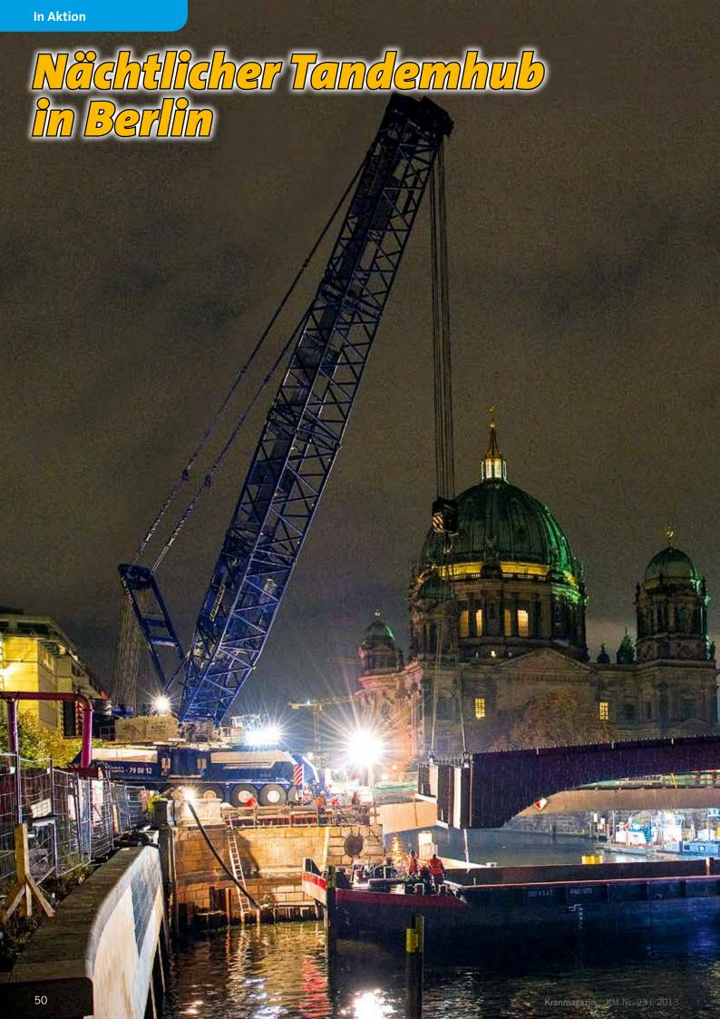
Friedrichsbrücke in Berlin: zwei Liebherr LG 1750 der Betreiber H.N. Krane und Maxikraft versetzten im Tandemhub Brückenteile, mit denen die Friedrichs-Zugänge zur weltbekannten Berliner Museumsinsel und darf nur wurden die Brückenteile an die von Fußgängern und Radfahrern genutzt werden. Der Einsatz, bei dem die Brücke 12,5 m auf 27 m verbreitert wurde, konnte nur in
