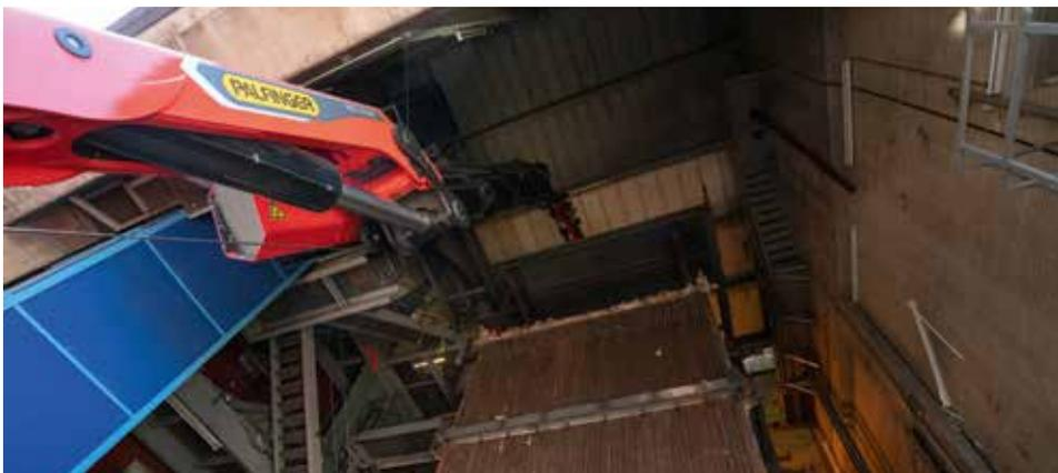
Der Palfinger PCC 115.002 bei der Demontage eines Heizkessels bei den Stadtwerken Gießen.
