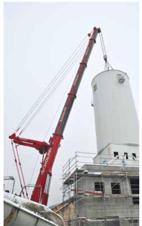
Erfolgreich abgesetzt: das neue Silo auf dem Turm des Transport-Beton-Werks.
