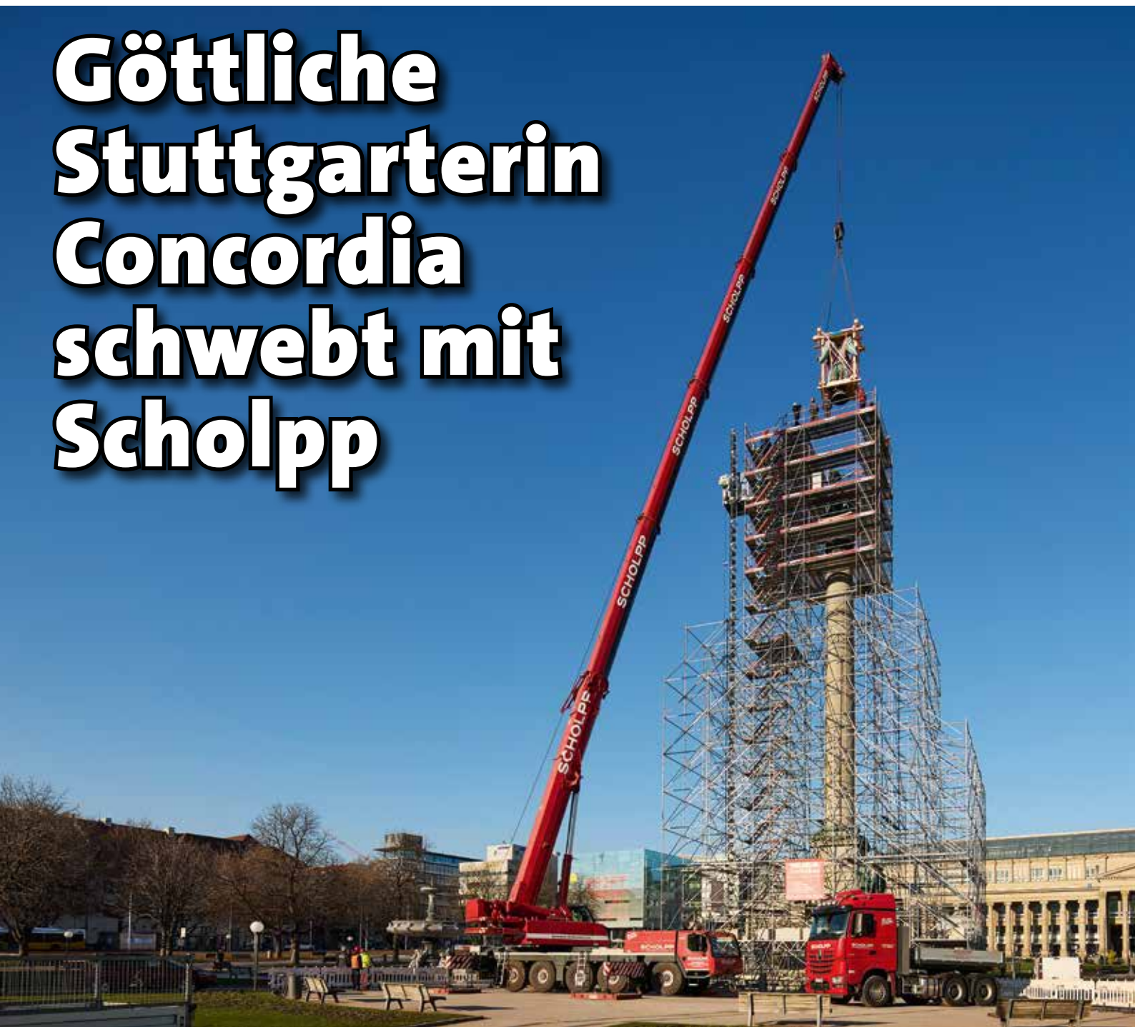
Scholpp-Einsatz mit dem LTM 1130-5.1 auf dem Stuttgarter Schlossplatz.
