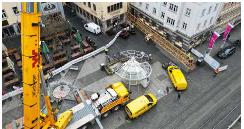
Der Einsatz erfolgte unter beengten Verhältnissen.
