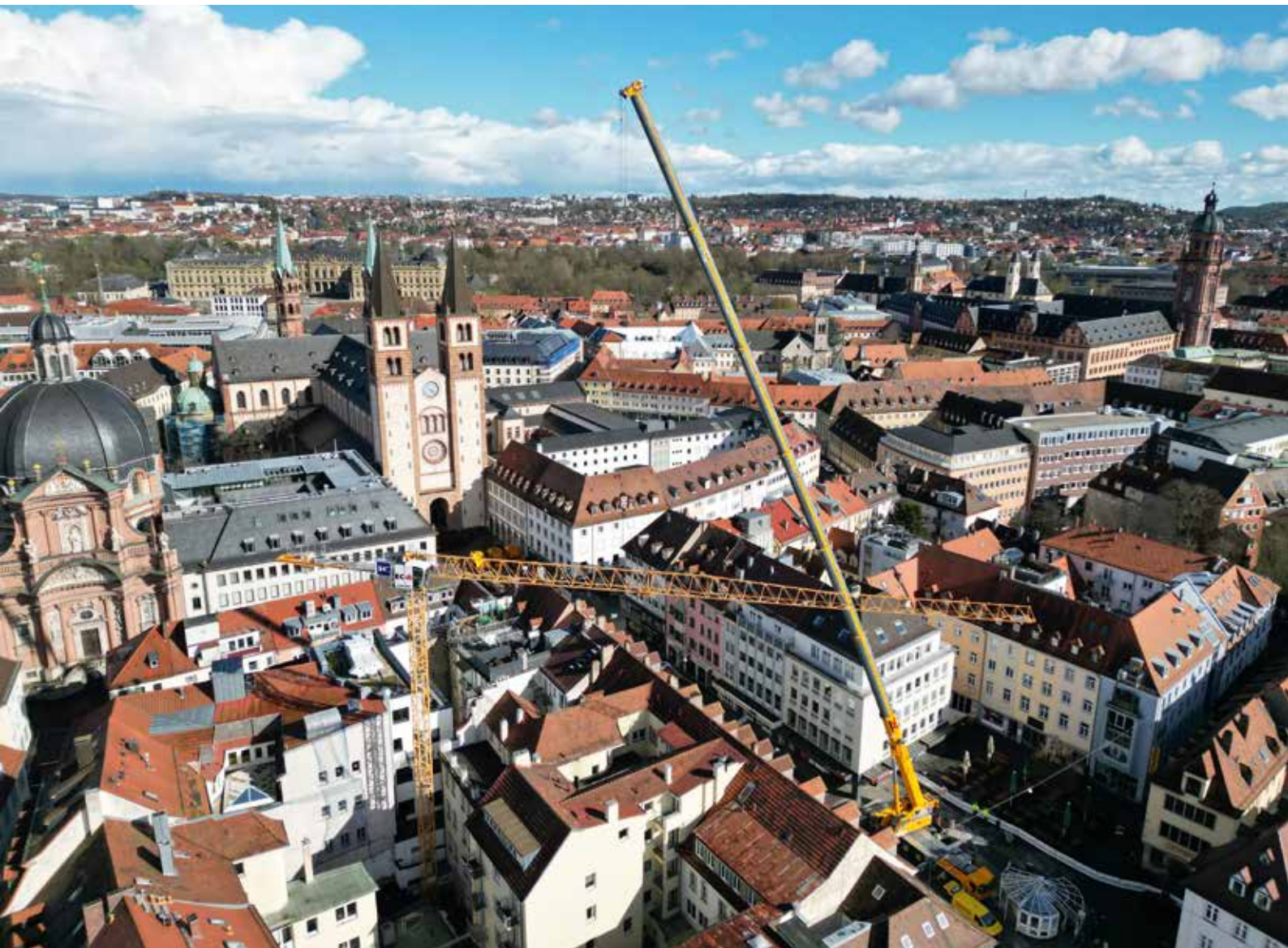
Der Turmdrehkran steht ... Einsatz an einem Tag erfolgreich abgeschlossen.
