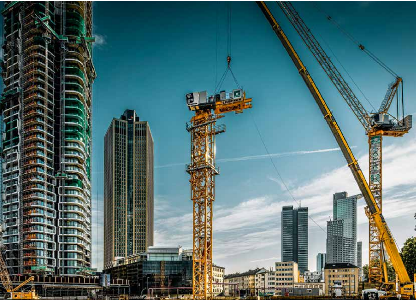
Blick zurück: Im Frühjahr 2019 wurden die beiden Liebherr-Verstellauslegerkrane montiert.
