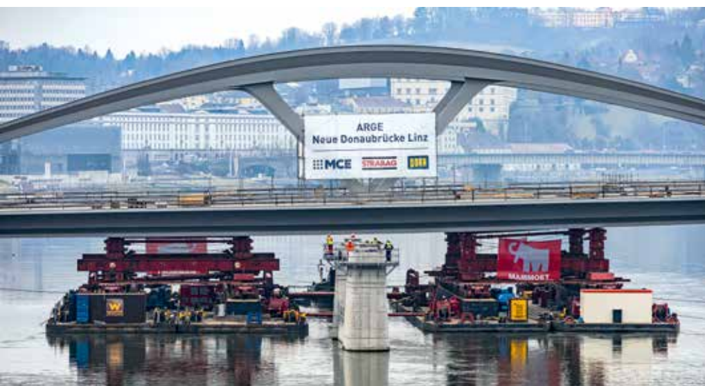
Absetzen auf die Brückenpfeiler zur Montage.
