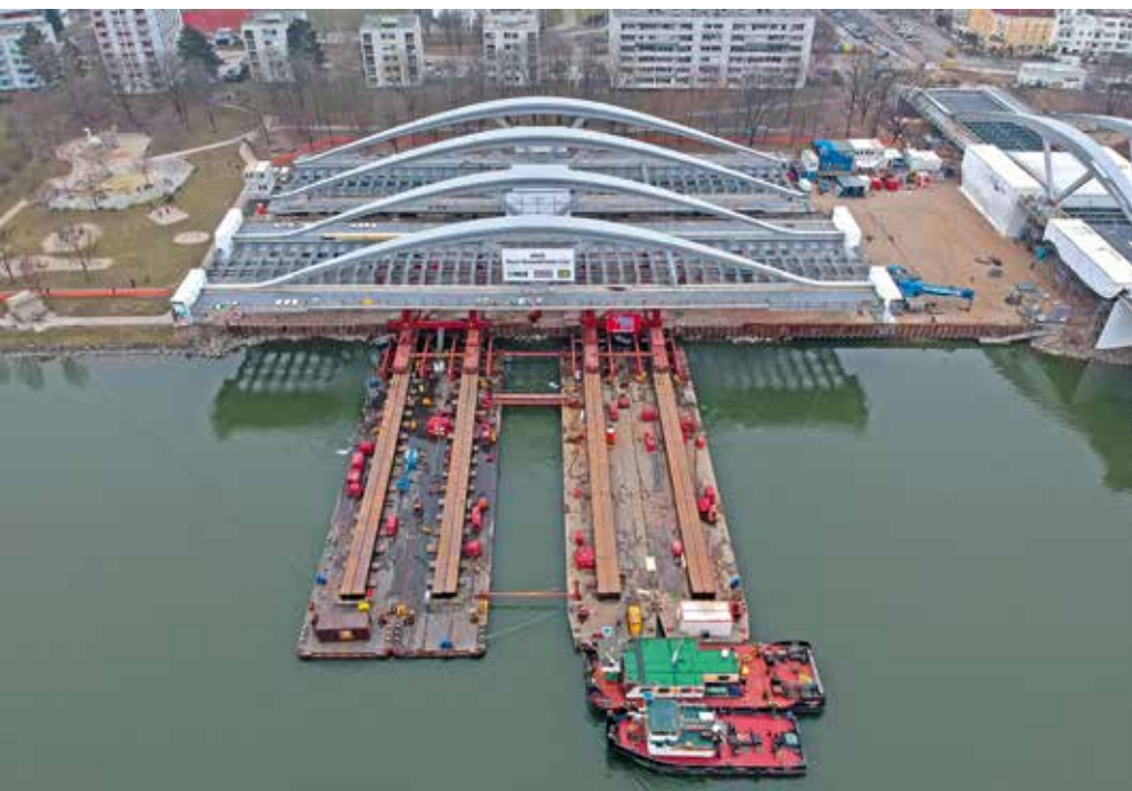
Auffahren auf die Pontons.
