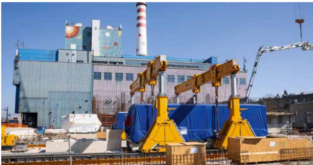
Auf der Baustelle wurde die Ladung schließlich von einem hydraulischen Hubportal auf einem 48 Meter langen Schienensystem für das finale Einheben übernommen.
