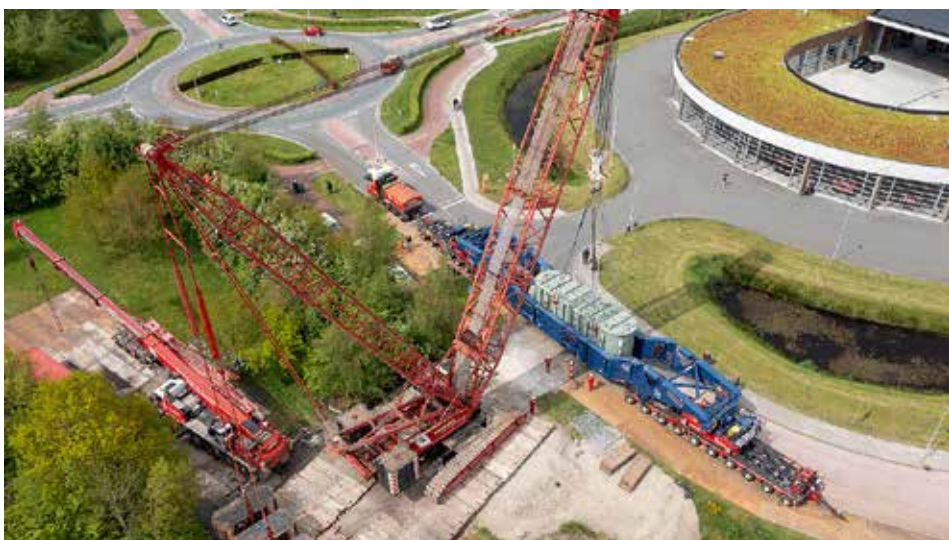
Mit Hilfe einer Girder Bridge wurden zwei Transformatoren transportiert.
