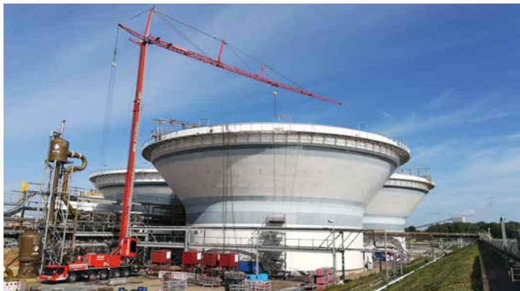
Ein Liebherr MK140 von ADW Mobilkrane im Industriemontage-Einsatz.
