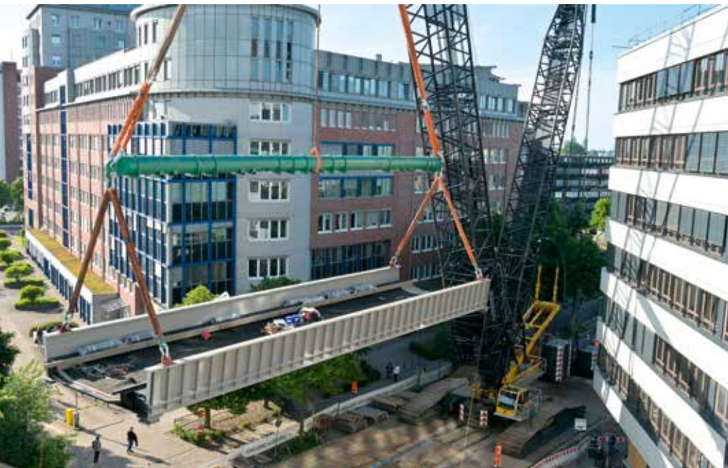
Ein Thömen Raupenkran hebt eine Brücke ein.
