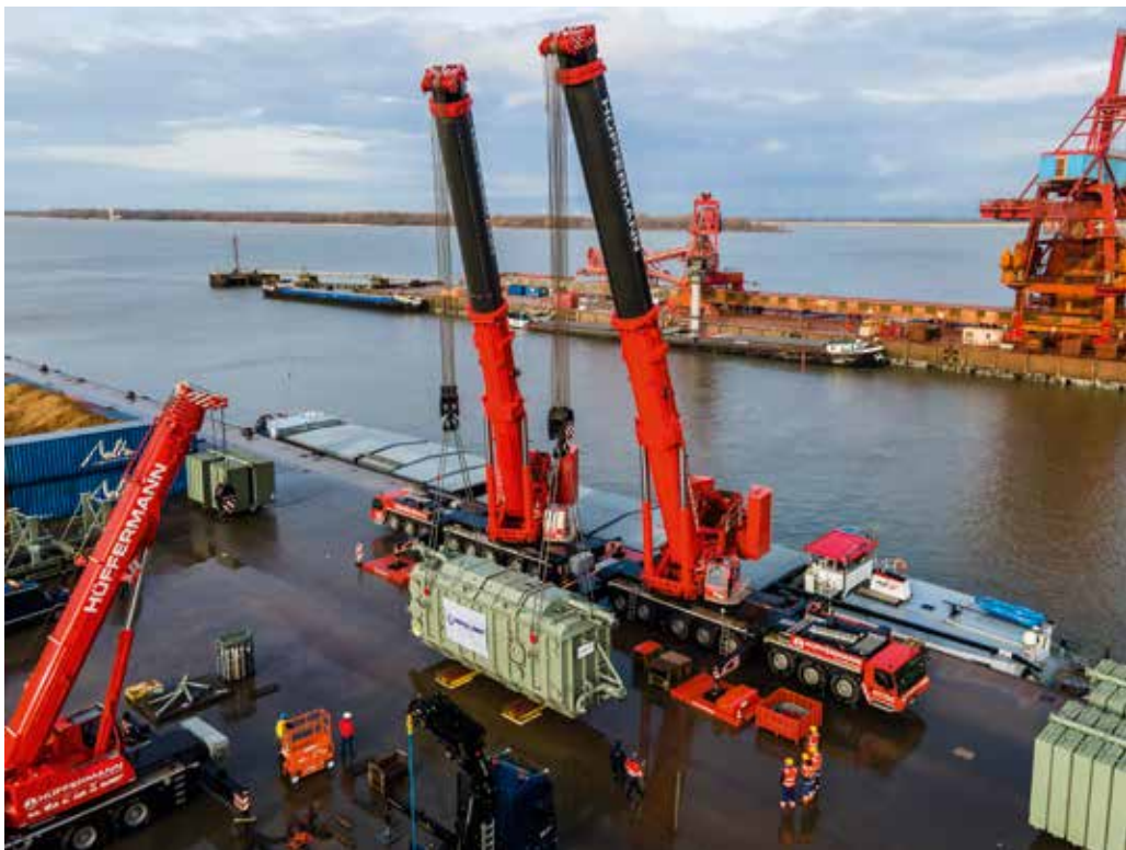
Zwei Liebherr LTM1500 des Hüffermann Krandienstes im Tandemhub im Hafen von Stade.
