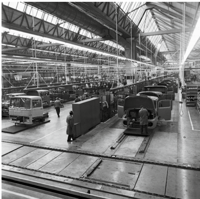
Am 1.10.1963 lief der erste Fahrerhaus-Rohbau vom Band.
