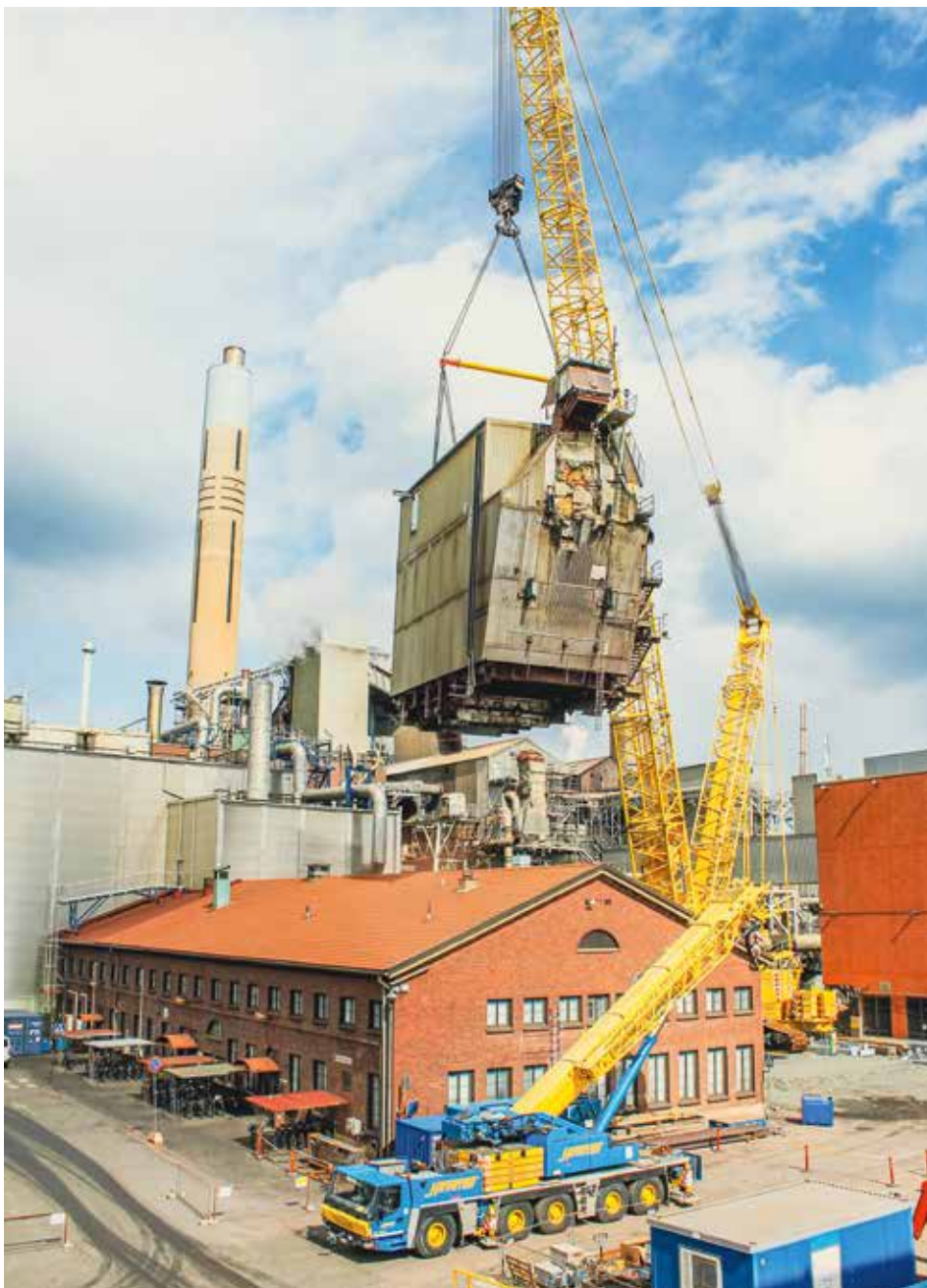
Der Kran hebt den 243 Tonnen Elektrofilter über das Bürogebäude hinweg.
