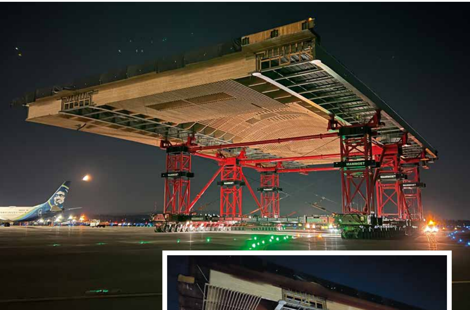
Der Transport der einzelnen Dachteile erfolgte in der Nacht, wenn der Flugbetrieb eingestellt war.
