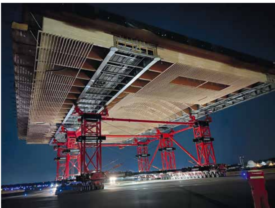
Der Transport der einzelnen Dachteile erfolgte in der Nacht, wenn der Flugbetrieb eingestellt war.
