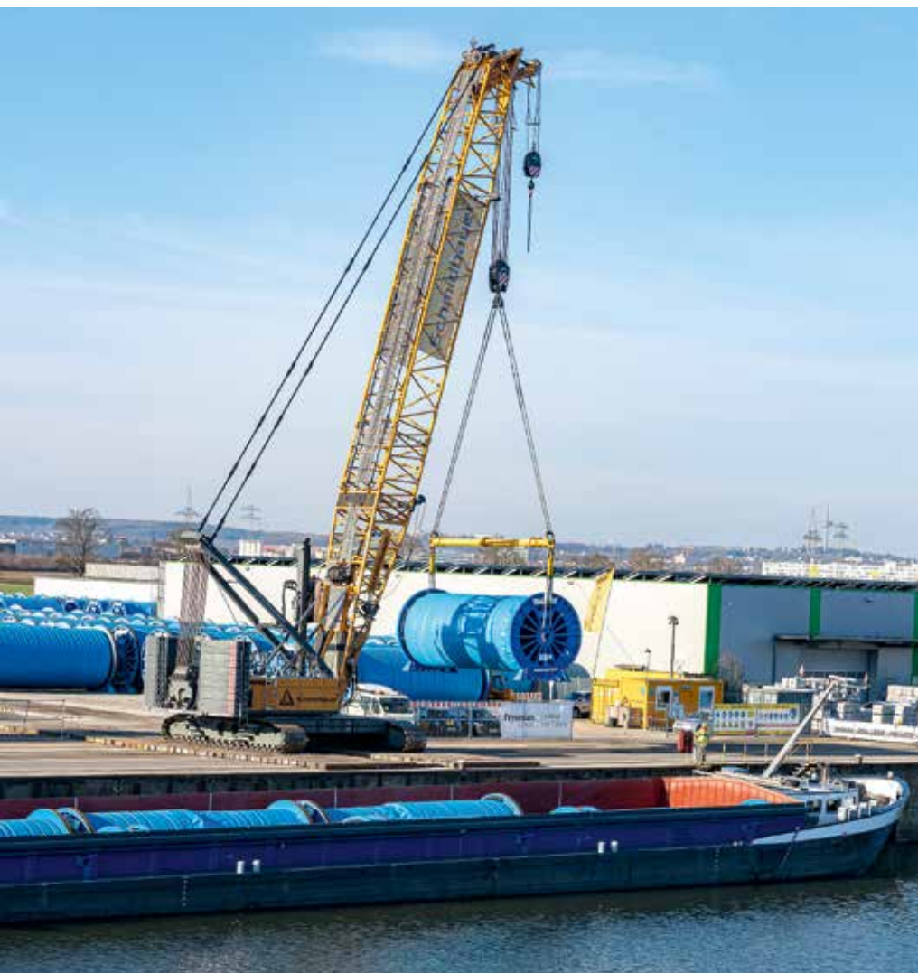
Die per Schiff angelieferten Kabelrollen werden in Regensburg von Raupenkränen ausgehoben.
