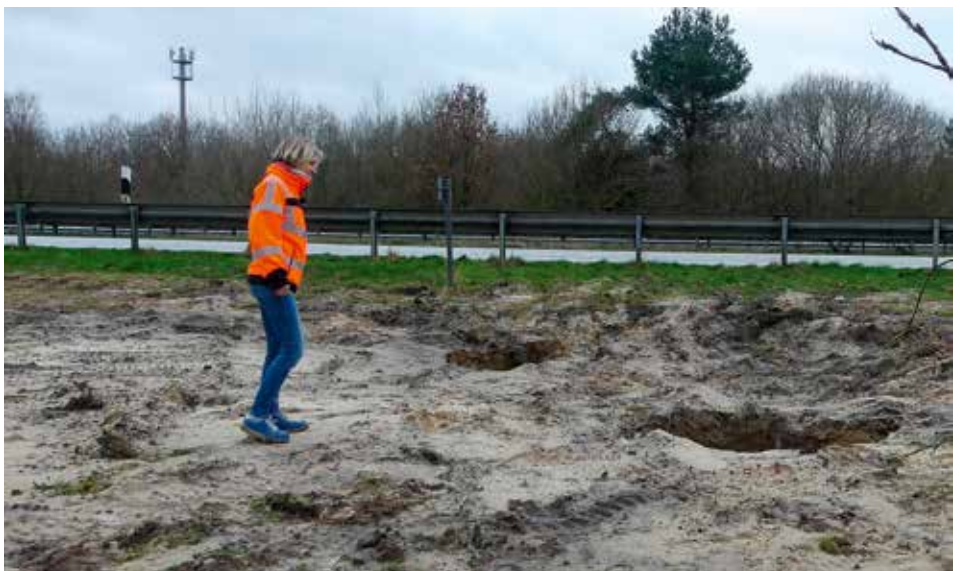
Die begrünte Böschung wurde mit großen Mengen Sand überspült.
