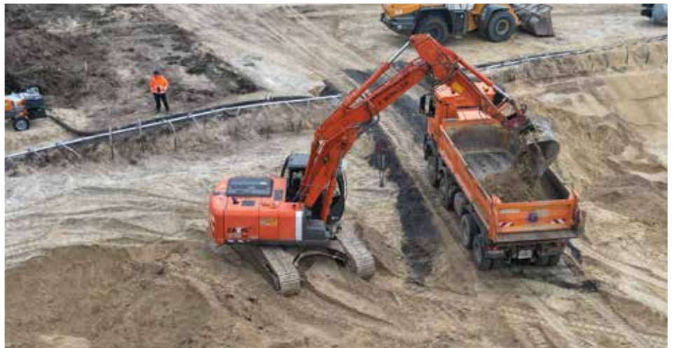
Gewaltige Sandmengen mussten zum Zwischenlager in 1,6 Kilometer Entfernung gebracht werden.
