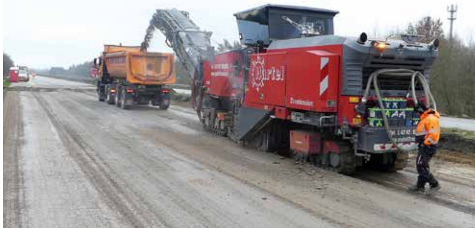
Zwei 50 Tonnen schwere Asphaltfräsen trugen die Fahrbahnschichten in Rekordzeit ab.
