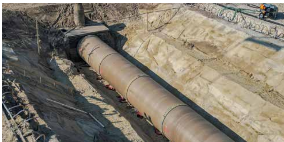
Der Stahlbetonübergang des Böschungsbereichs mit der neuen Verrohrung.
