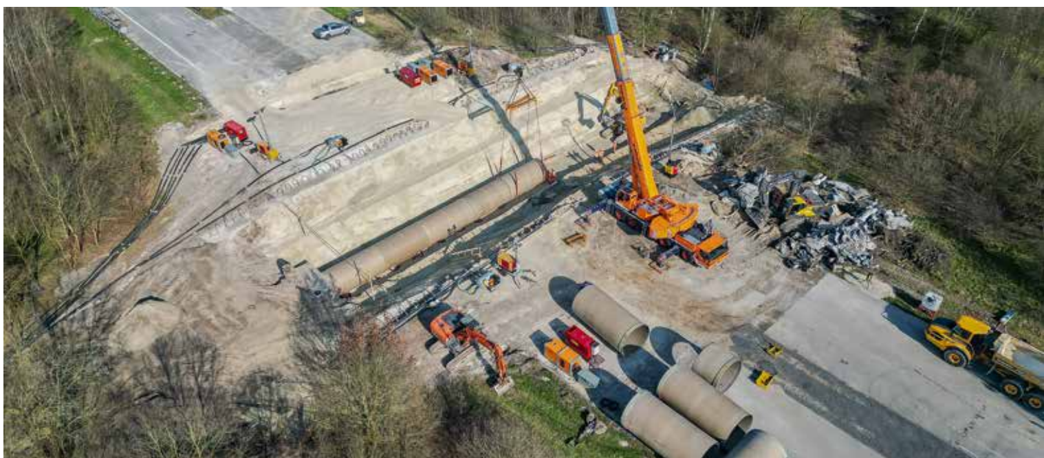
8 Meter lange Rohrschüsse wurden mit einem Teleskopkran in die 9 Meter tiefe Baugrube gehoben.
