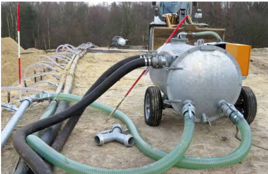
Mehrere Pumpen saugten das Grundwasser über 100 Minibrunnen aus der 9 Meter Tiefe.
