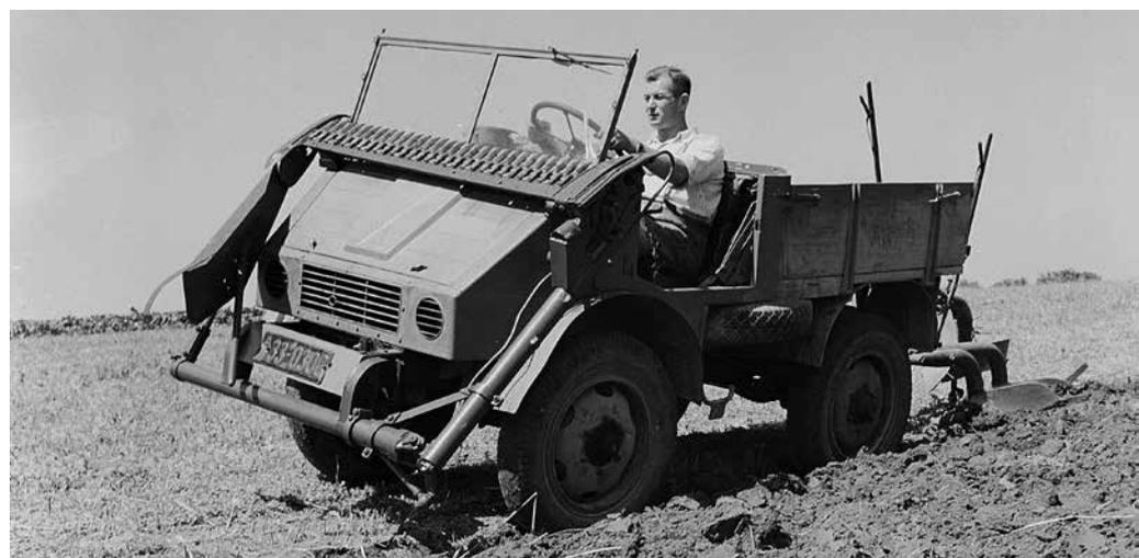
Diese Aufnahme aus dem Sommer 1947 zeigt den Prototyp U1. Das Fahrzeug sowie das Mähwerk an der Front wurde bei der Metallwarenfabrik Erhard & Söhne in Schwäbisch Gmünd entwickelt und gebaut.
