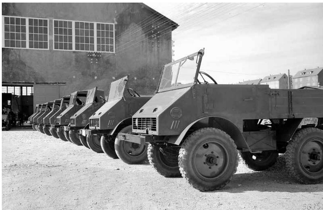
Aufnahme auf dem Firmengelände der Firma Boehringer in Göppingen. Im Hintergrund die Unimog-Halle, wo die Fahrzeuge gefertigt wurden. Anfangs wurden pro Woche sieben bis neun Fahrzeuge produziert. Ein interessantes Detail des dritten Fahrzeugs: Ein zusätzlicher Scheibenwischer auf der Beifahrerseite.
