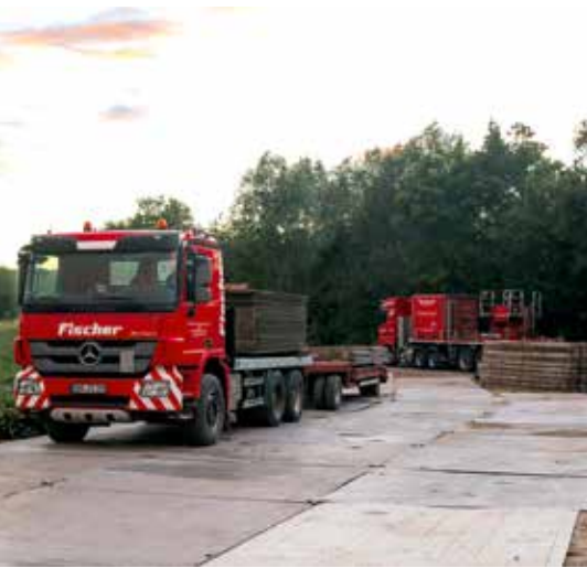
Fanden eher weniger Beachtung, waren aber wichtige Helfer und Wegbereiter: die Fahrzeuge der Firma Fischer, die mit Ladekränen 1.000 qm Aluminium- und 500 qm Stahlplatten verlegten, um insbesondere ein Einsinken der schweren Last zu verhindern.
