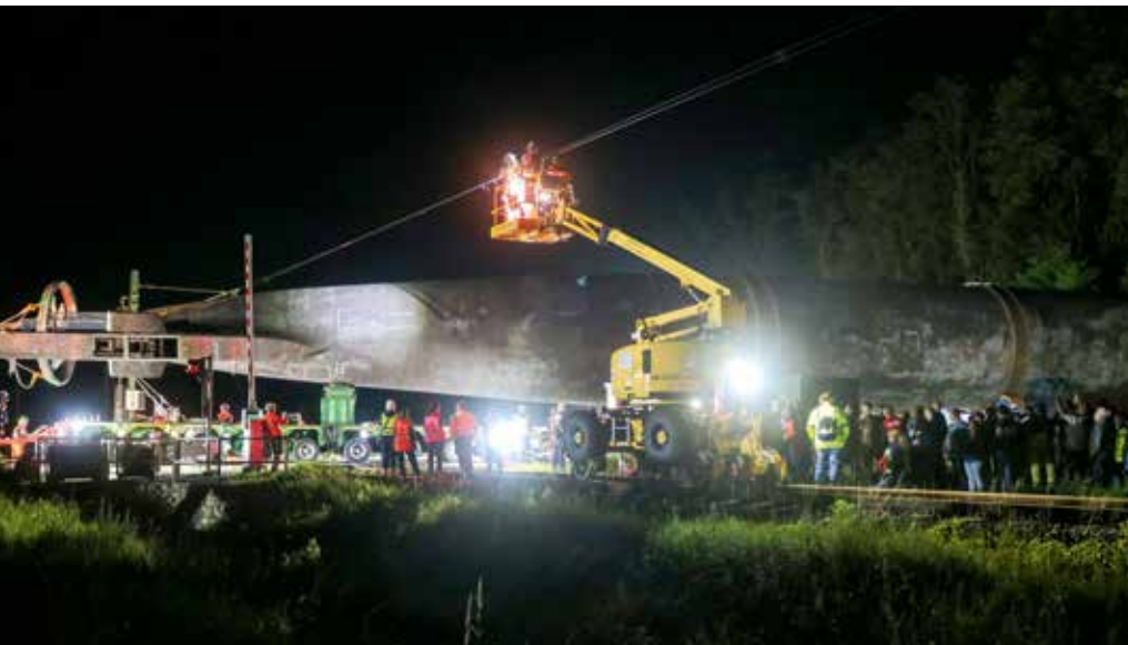
Querung eines Bahnübergangs: Die Oberleitung muss mit Hilfe einer „Railway“-Hubarbeitsbühne noch etwas angehoben werden. Bild: Klaus Soerensen
