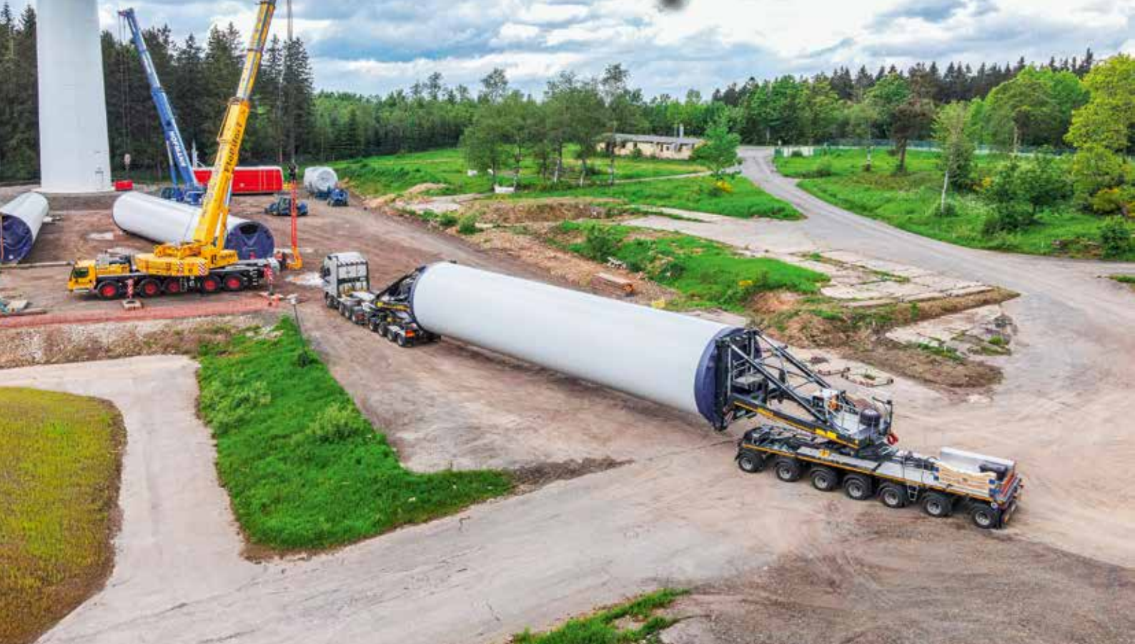
Luftaufnahme der Transporteinheit beim Erreichen des Abladeorts.
