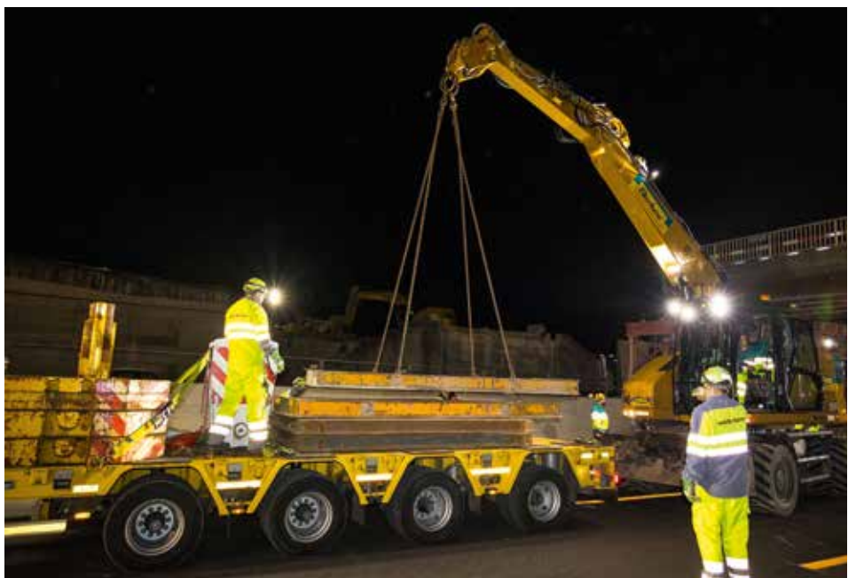
Abladen der Kran-Unterlegplatten mittels Mobilbagger.
