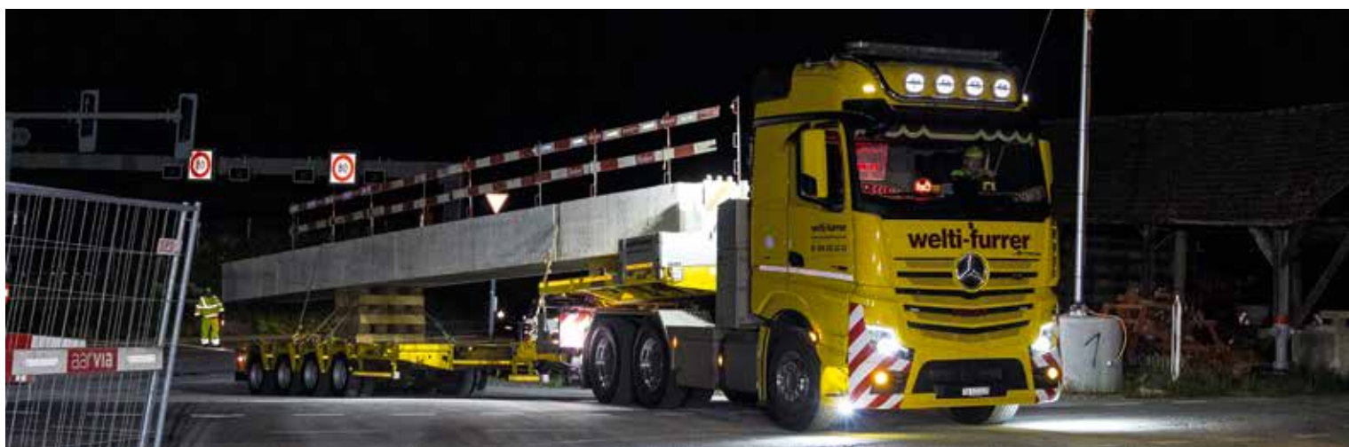
Zwischen dem Installationsplatz und der Baustelle befindet sich nur eine Straße, welche jeweils überquert werden muss.
