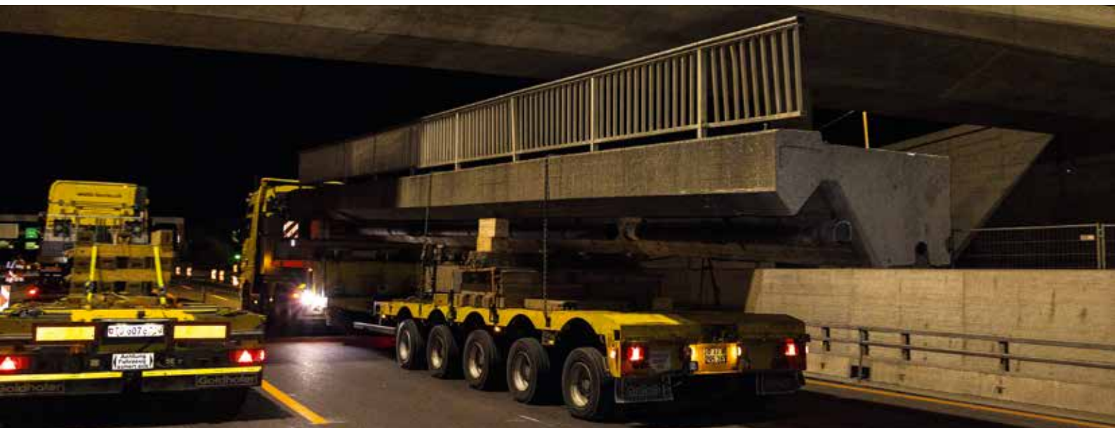
Das asymmetrische Teil wurde für den Transport mit Hölzern unterlegt.
