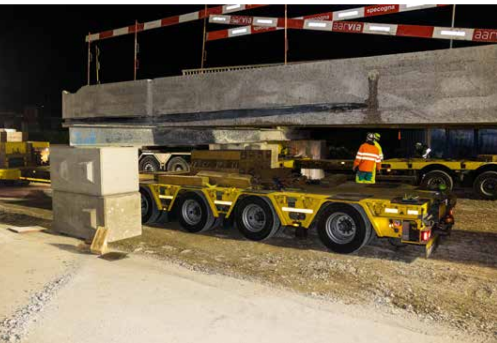
Das Element wurde mit der Luftfederung abgesetzt.
