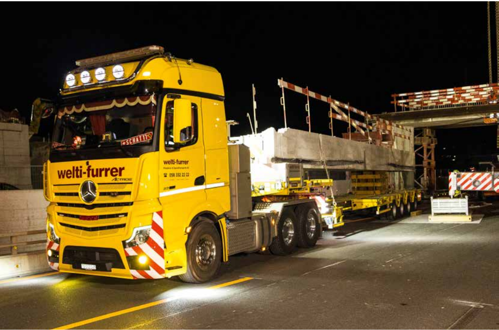
Das Element ist fertig gesichert und wird abtransportiert.
