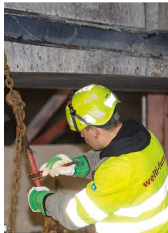
Sichern des Betonelements.
