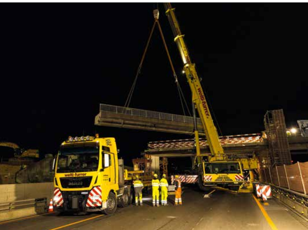
Das erste Brückenstück wird abgehoben und zum Tieflader geschwenkt.
