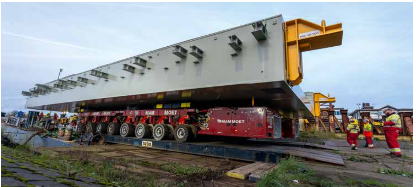
... der SPMTs vom Lastkahn transportiert.
