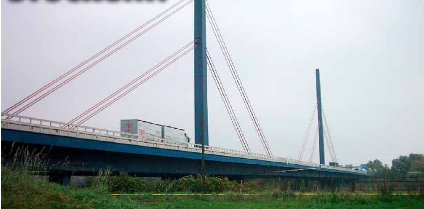
Die Elbbrücke der A1 (Norderelbbrücke) bei Hamburg zwischen Autobahnkreuz Hamburg-Süd und Autobahndreieck Hamburg-Süd-Ost 2006. Foto: GeorgHH
