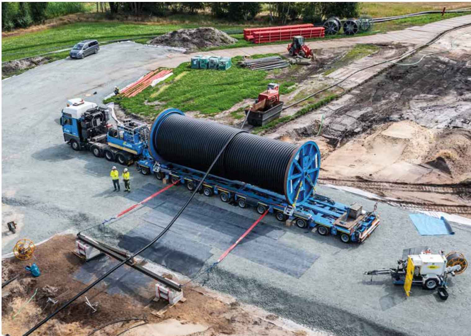
An mehreren Abspulplätzen in Deutschland hat der Abspulvorgang bereits begonnen. Ein effizienter Einsatz von Personal und Technik ermöglicht den reibungslosen Ablauf an mehreren Baustellen gleichzeitig.
