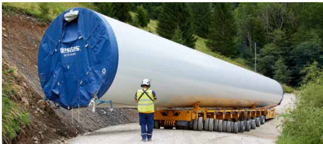
Dank Pendelachsen können auch Bodenunebenheiten mit der SPMT-Einheit von Goldhofer ausgeglichen werden.
