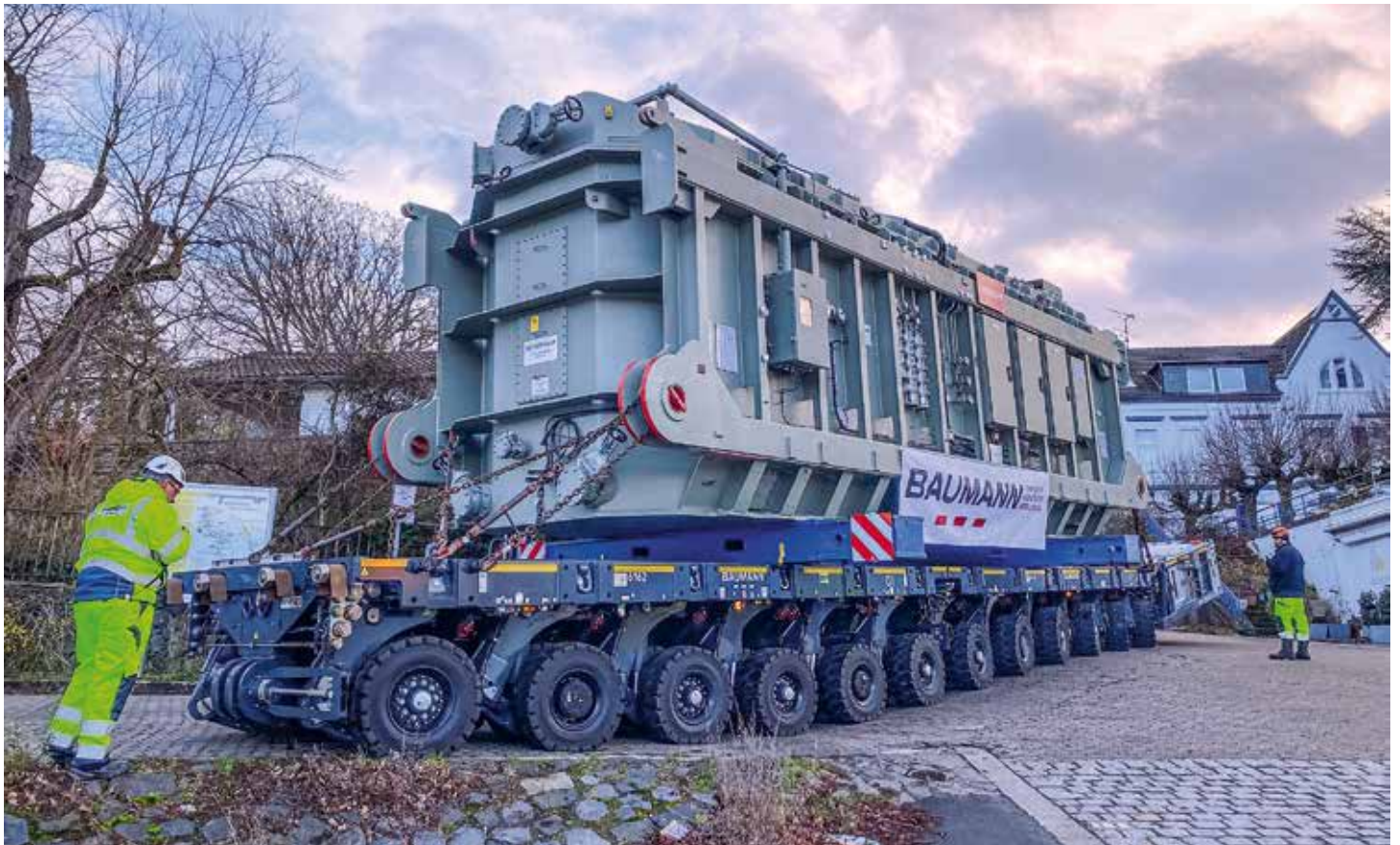
Engere Kurven und Bodenebenheiten stellten den Cometto SPMT von Baumann dabei vor kein Problem.
