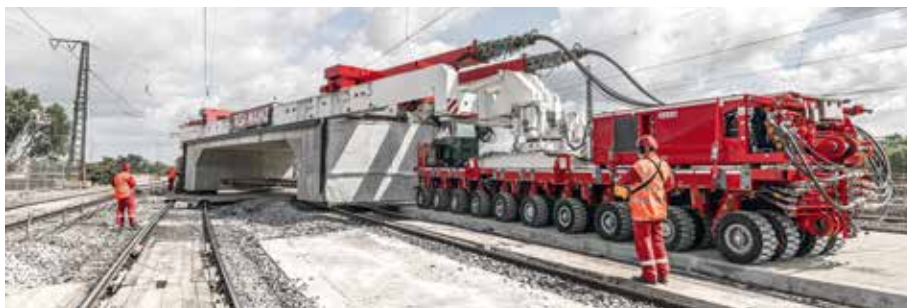
Schwerlastlösung für den Brückenbau: Die SCHEUERLE SPMT Plattformtransporter ermöglichen den sicheren und präzisen Transport von Brückenelementen – selbst bei extremen Lasten und anspruchsvollen Baustellenbedingungen.
