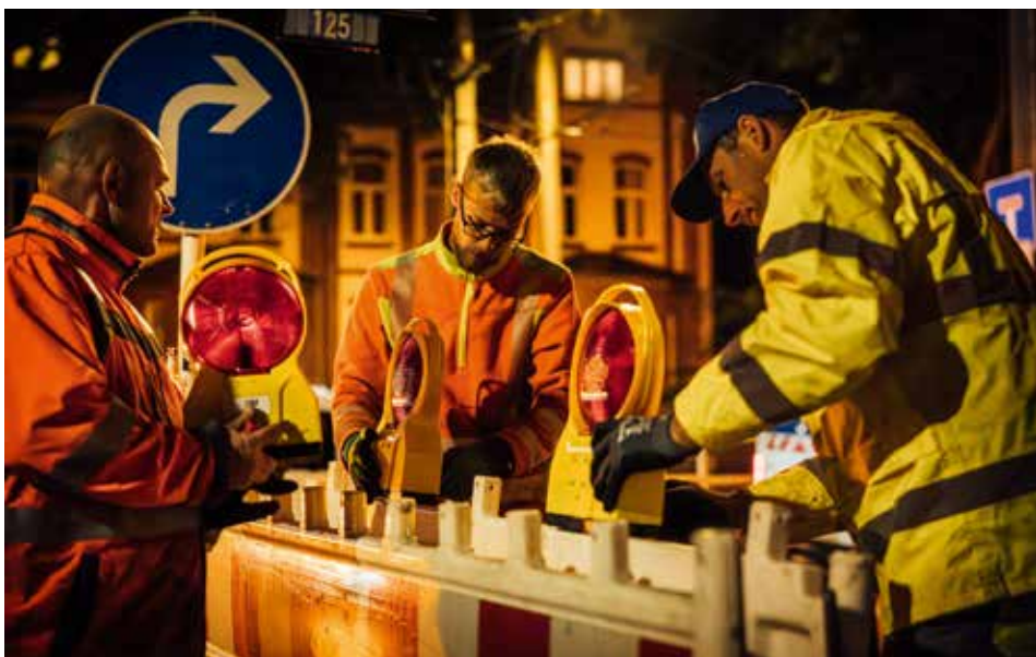
SLT Verkehrstechnik wird in Stellung gebracht.
