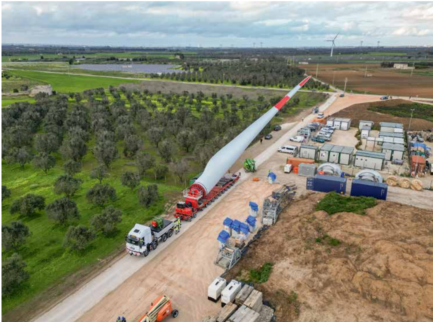
Der Lkw erreicht den Windpark „Mondonuovo“. Das Projekt umfasst die Installation von 9 Windturbinen mit einer Leistung von jeweils 5,9 Megawatt, was einer Gesamtleistung von 53,1 Megawatt entspricht.
