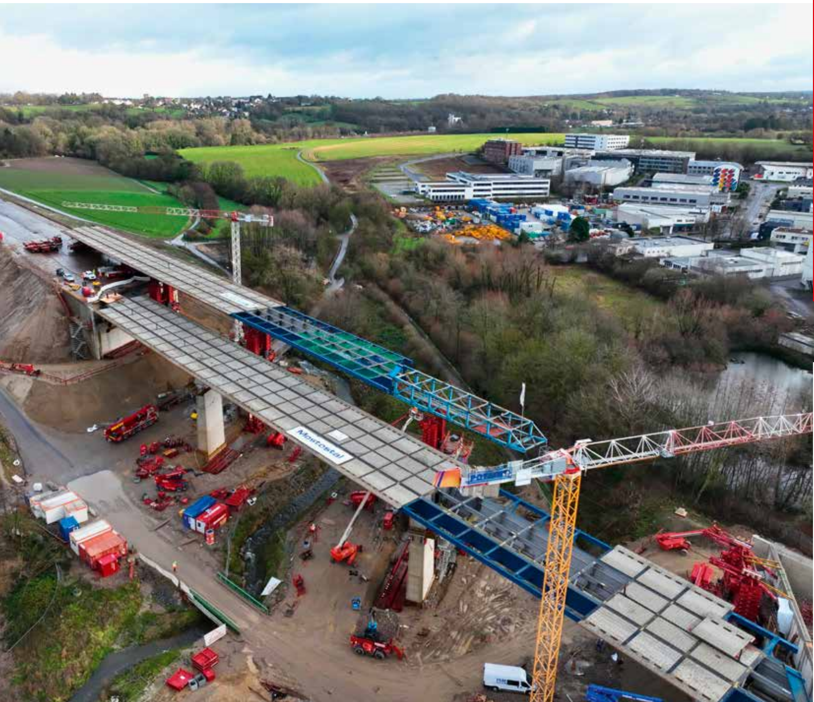
Verschub des zweiten Teilbauwerks der Haarbachtalbrücke.
