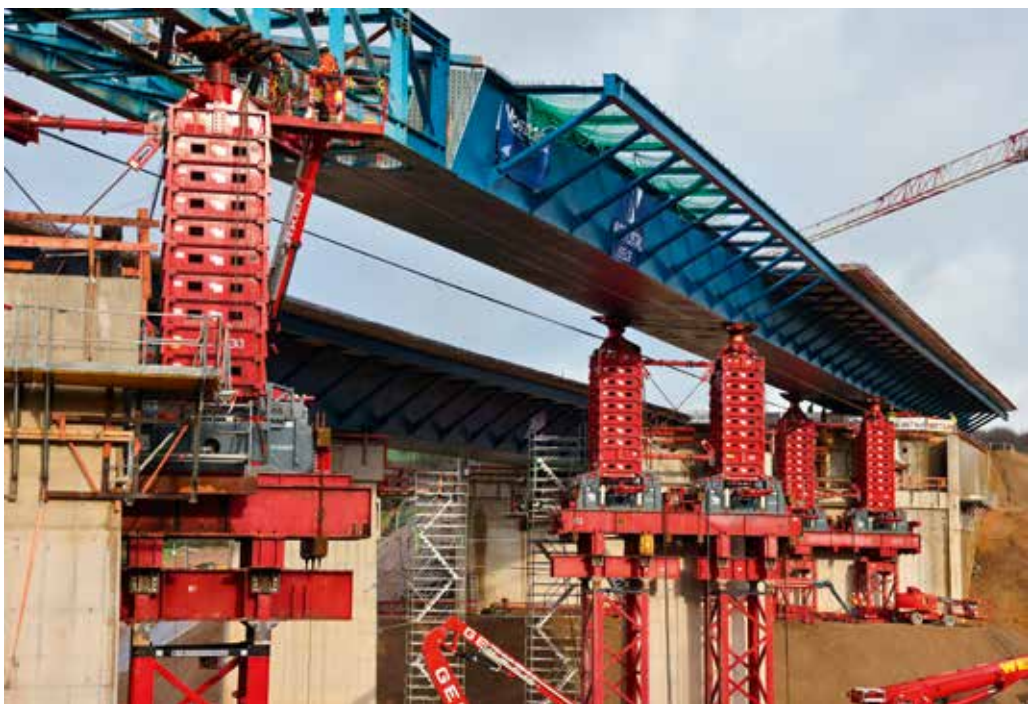
Temporäre Türme mit dem Mammoet Mega Jack 800-System.
