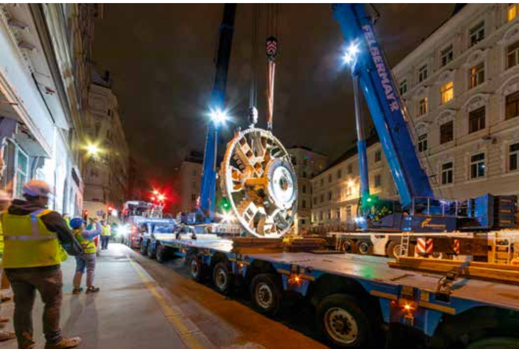
Das rund 78 Tonnen schwere Schneidrad wird im Tandemhub mit einem 400- und einem 250-Tonnen-Kran am Augustinplatz ausgehoben.
