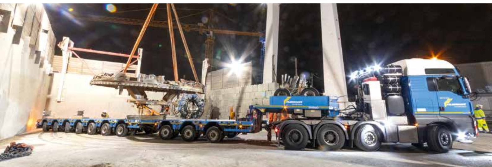
Am Ziel angekommen, hebt ein Portalkran um 3 Uhr morgens das Schneidrad vom Semi-Tiefelader.
