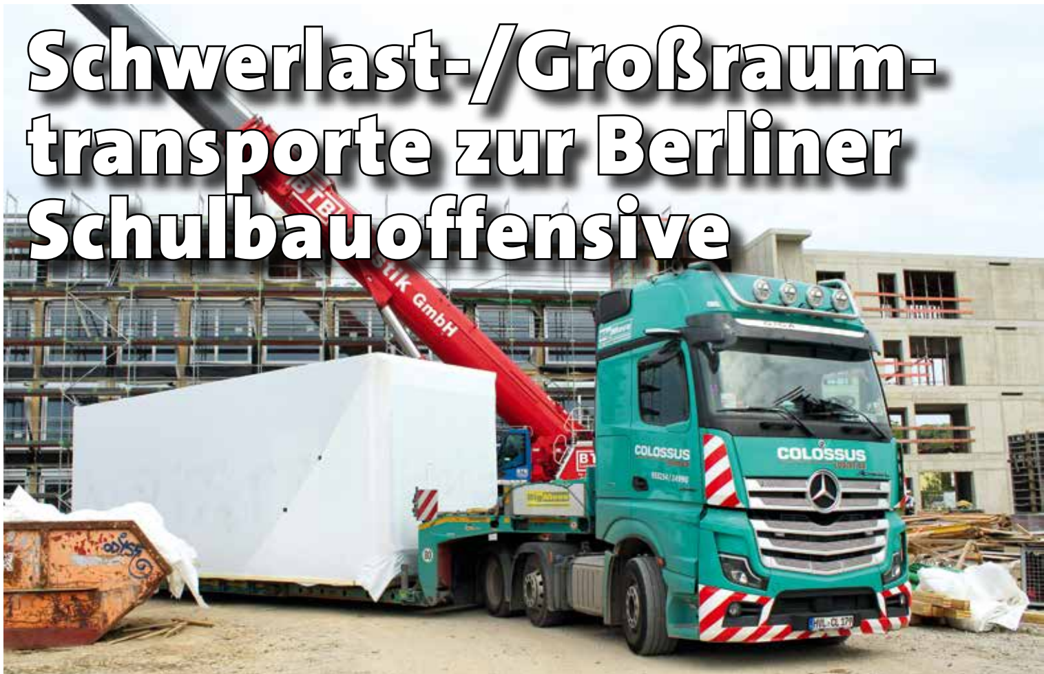
Ein Mobilkran nimmt das neue Gebäudemodul in Empfang.
