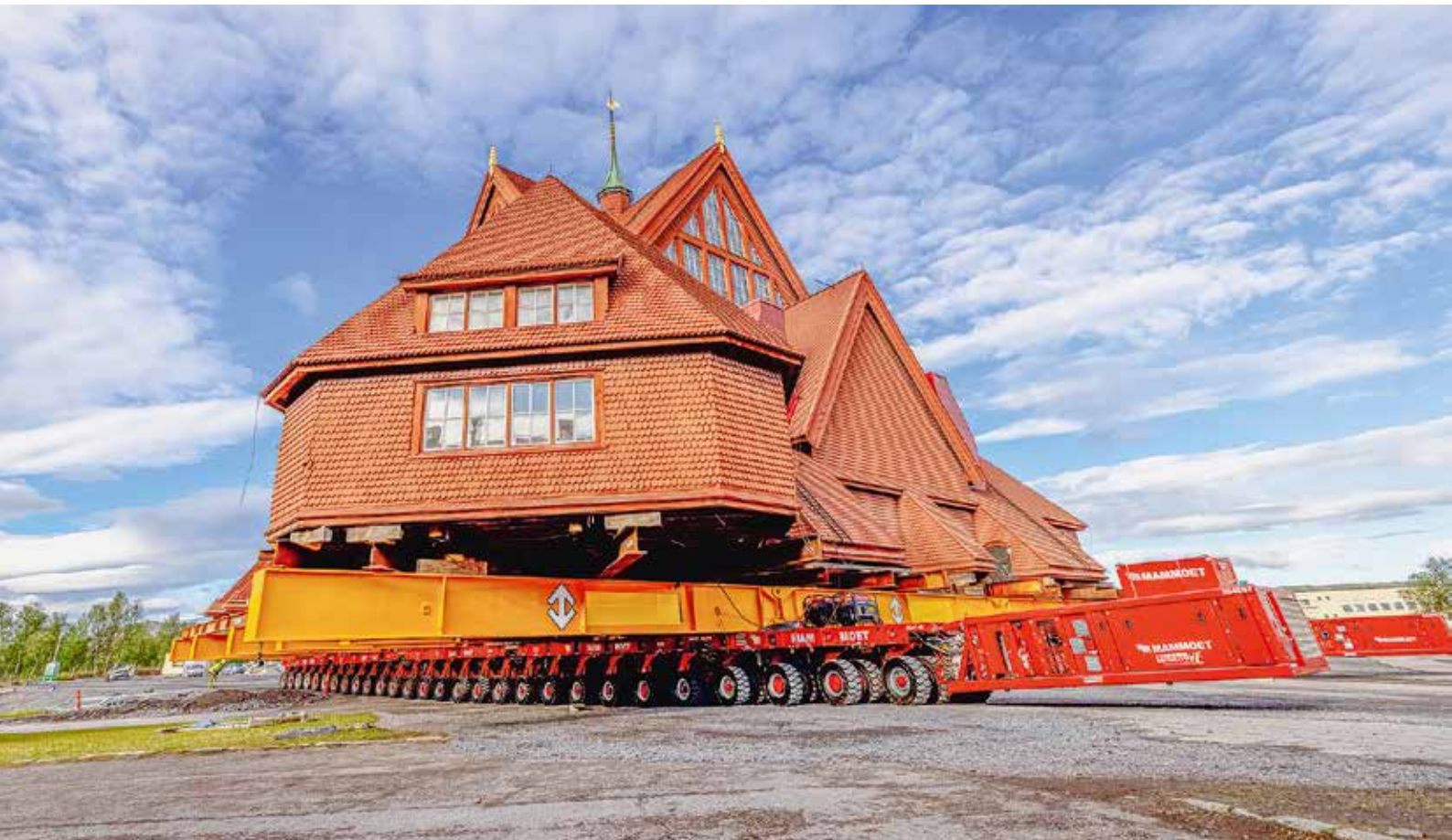
... und der hydraulische Hub von 700 Millimetern ermöglichten den präzisen und problemlosen Transport.
