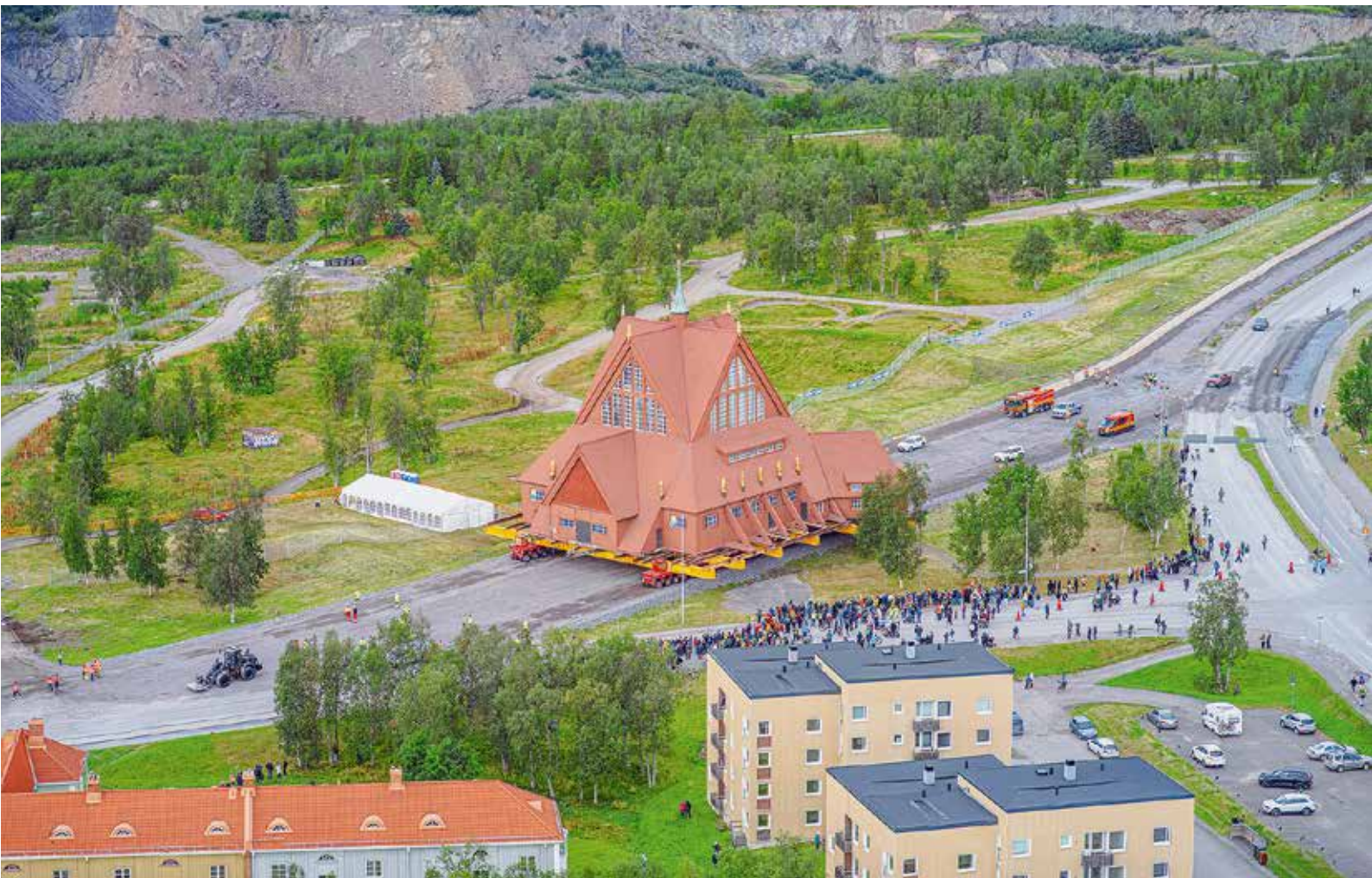
Für den Transport wurde die Straße verbreitert.
