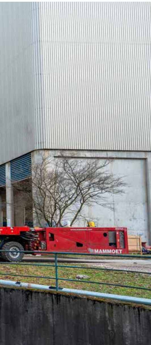
Die Gasturbine steht für den Schwerhub und die Installation bereit.
