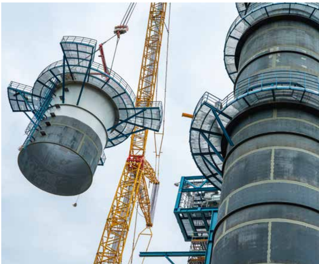
Schwerhub eines Stapelmoduls für den großen Schornstein.
