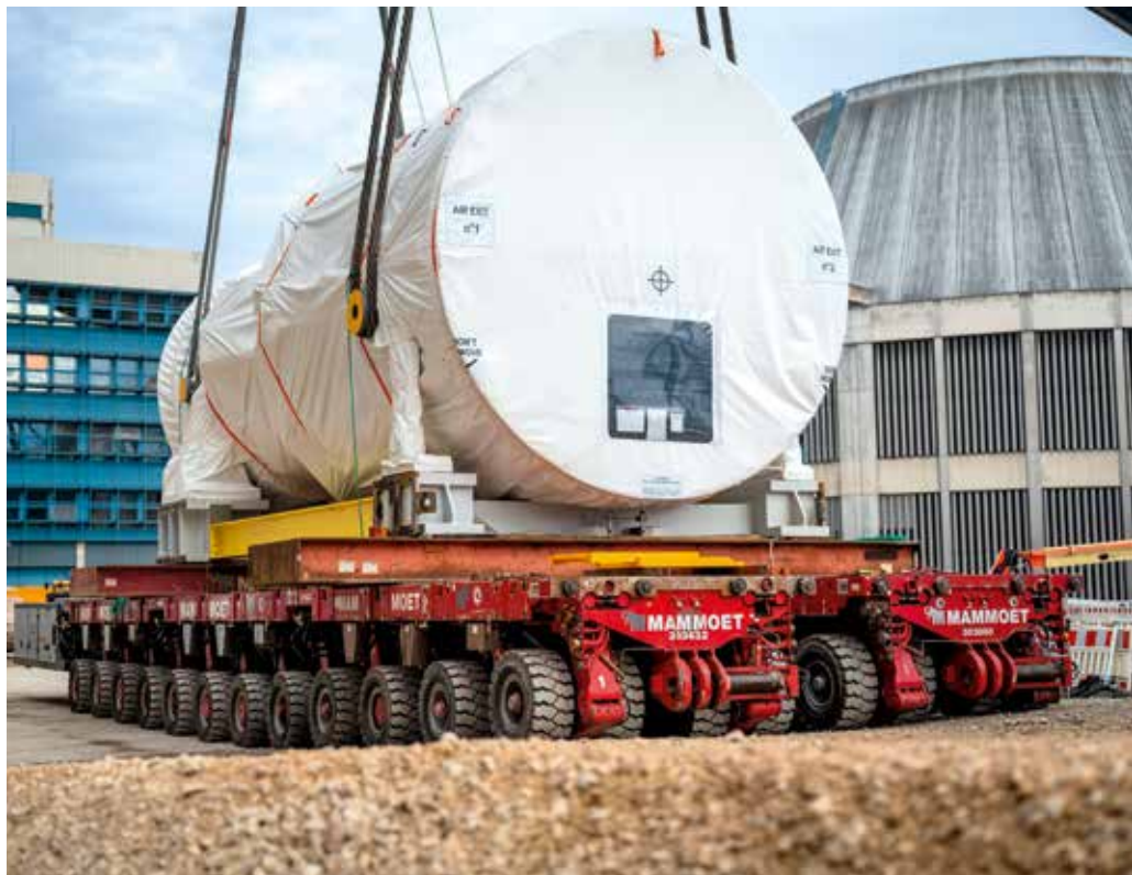
Die Gasturbine steht für den Schwerhub und die Installation bereit.
