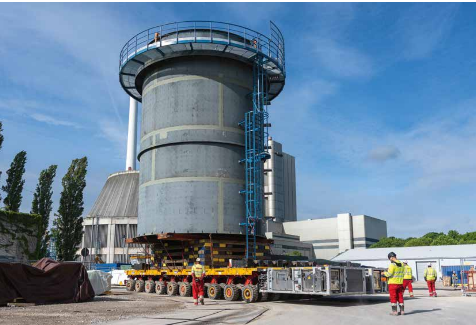
SPMT-Transport eines Stapelmoduls.
