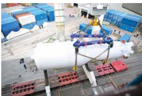
Absenken eines Dampferzeugers auf Power-Steering-Trailer.
