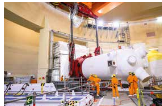
Verschieben eines Dampferzeugers durch die erhöhte Schleuse des Reaktorgebäudes.
