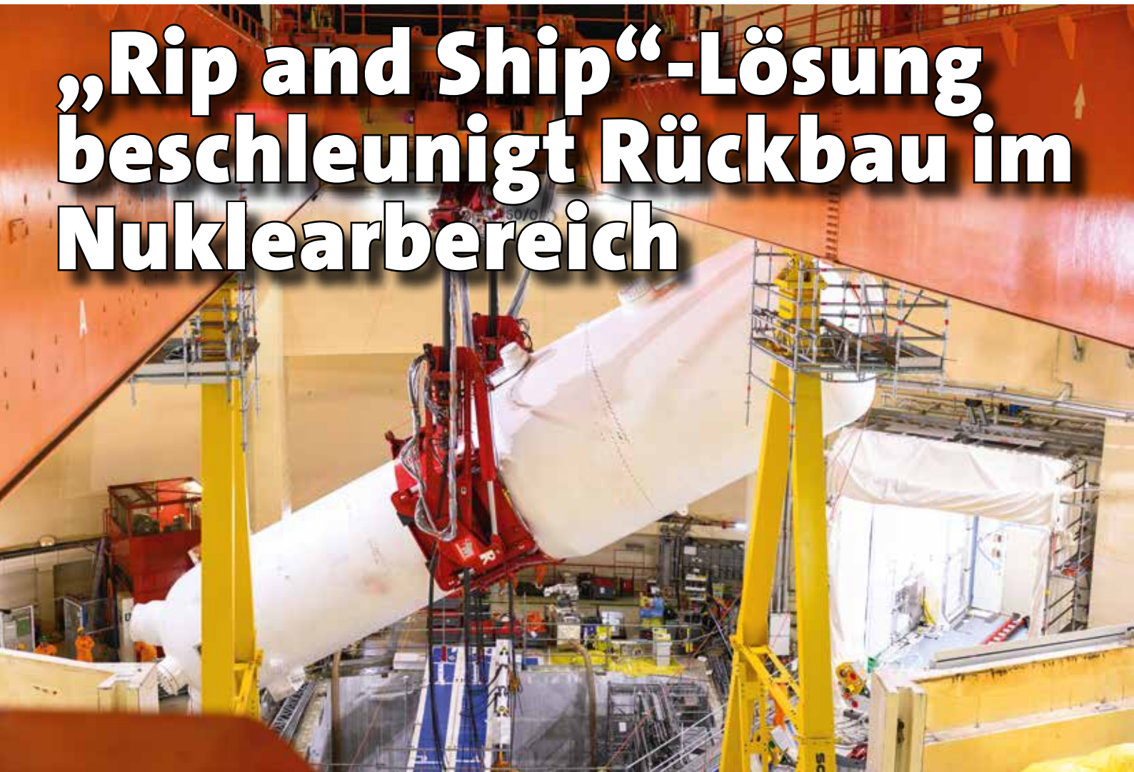
Ein Dampferzeuger ist am DHS-500-System befestigt.
