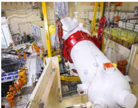
Kippen eines Dampferzeugers in die horizontale Position.
