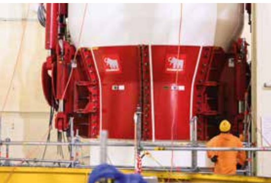
Verstellbarer Greifring zum sicheren Fassen der zylindrischen Dampferzeuger.
