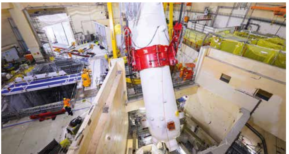
Anheben und Kippen eines Dampferzeugers mit dem DHS-500-System.
