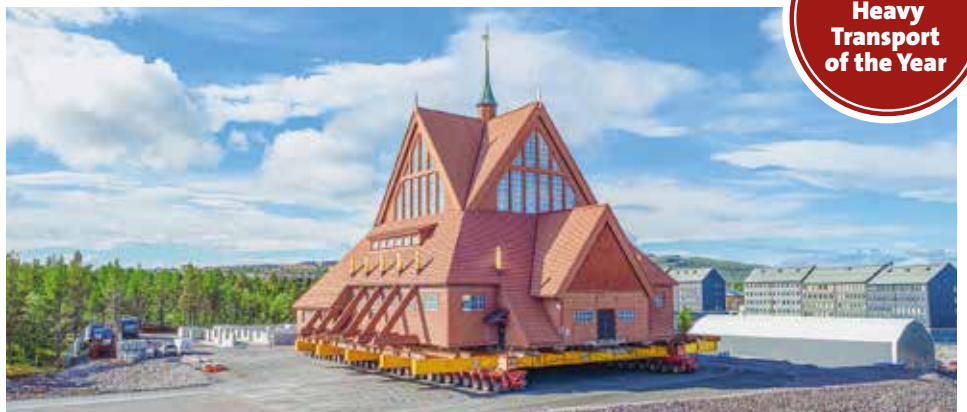
Die Kirche ist sicher am neuen Standort angekommen.
