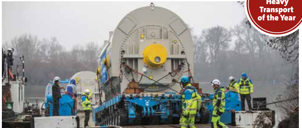
Über die RoRo-Rampe rollte der SPMT mit dem Generator aus dem Schiff aus und fuhr direkt weiter durch die Stadt Mako bis zum Umladepplatz.
