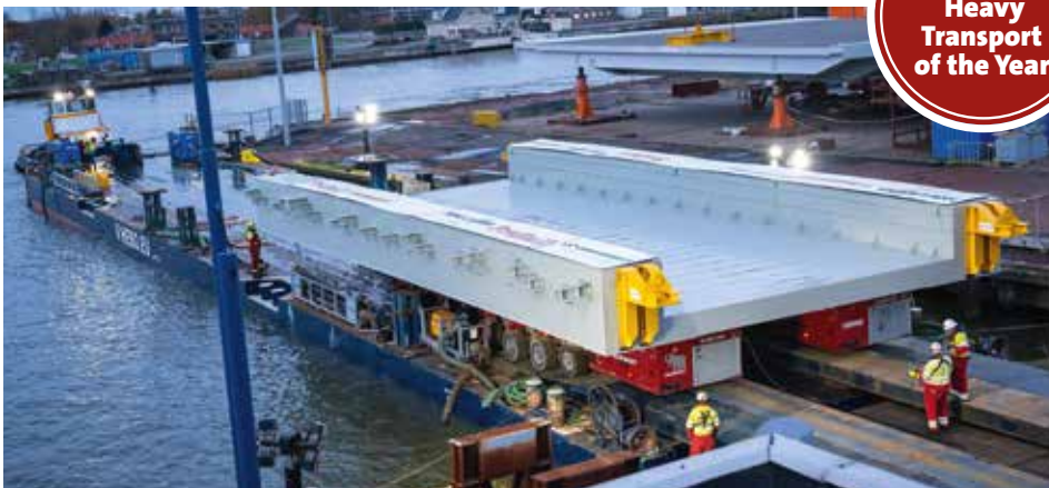
Der Brückenabschnitt wird mithilfe der SPMTs vom Lastkahn transportiert.
