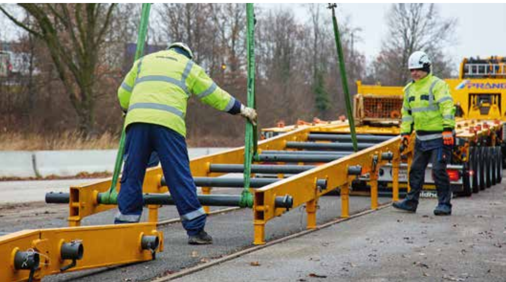
Die aus mehreren Teilen bestehende Schienenauffahrtrampe wird montiert.
