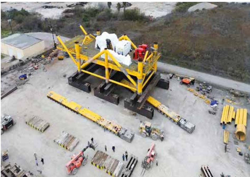
Die SPMT-Einheiten werden in Position gebracht.
