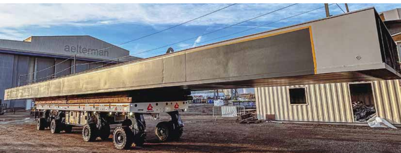
Auch sehr lange Stahlbauteile stellen den Eco1000 vor kein Problem.
