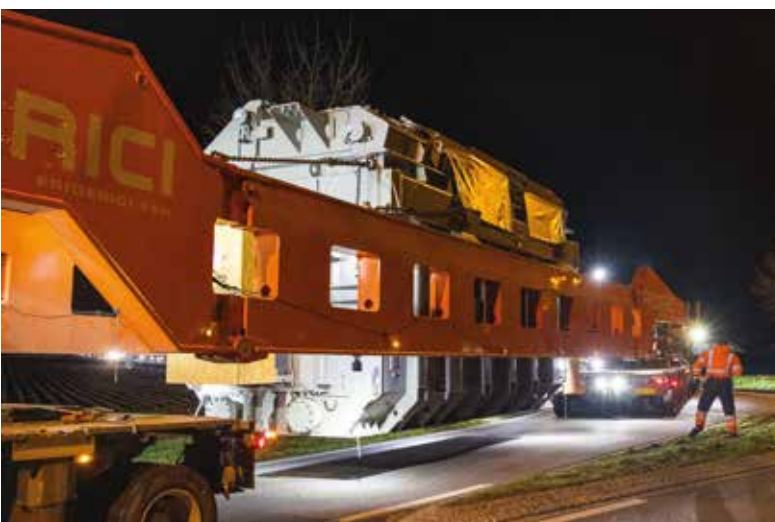
Der Trafokessel kommt vorbei.
