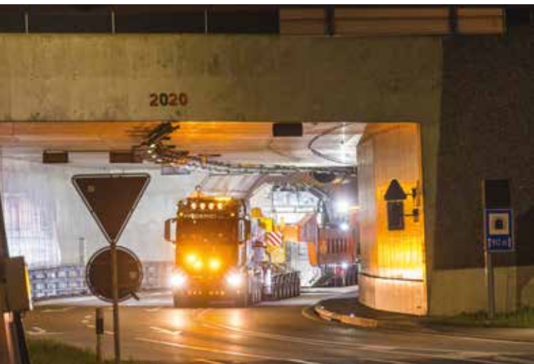
Umfahrungstunnel Sins: Der Tunnel ist gerade hoch genug.
