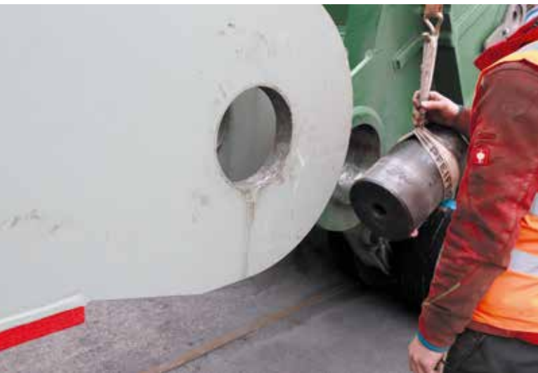
Bei der Aufnahme werden die Aufnahmepunkte am Transformator und an der STB 320 miteinander verbolzt.
