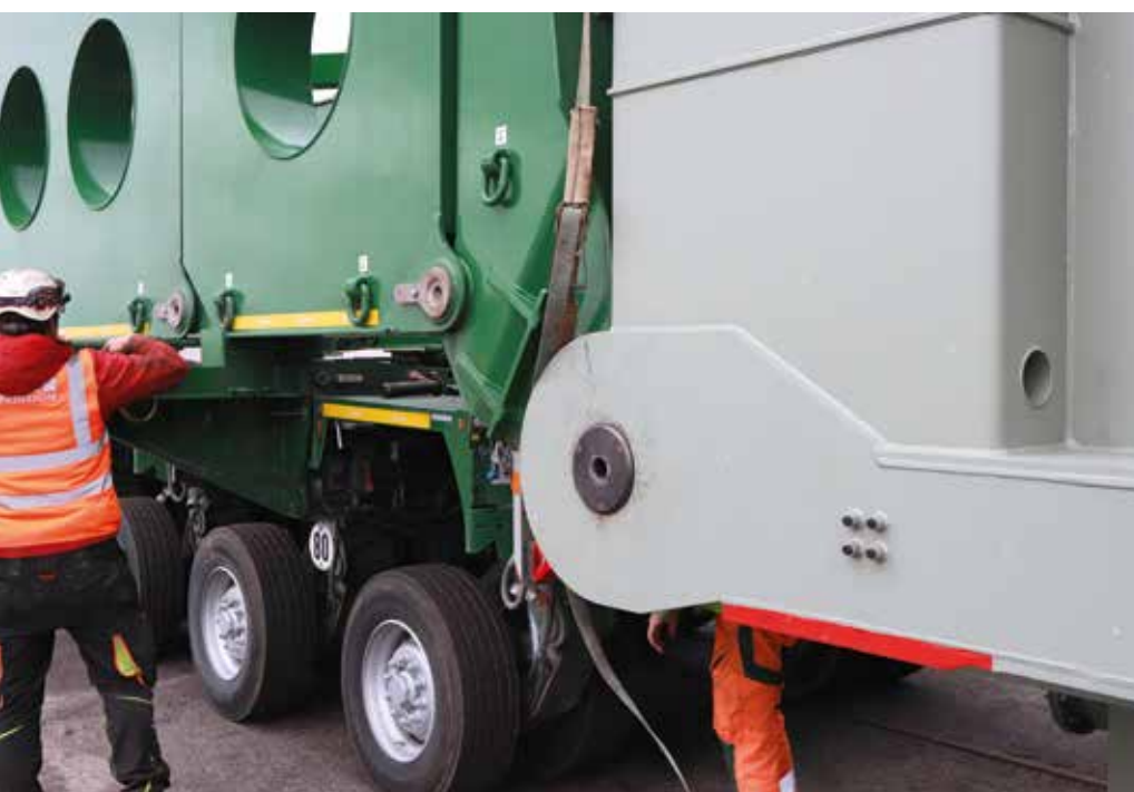
... die Augen für die Verbolzungen zügig und präzise zueinander ausgerichtet werden konnten.
