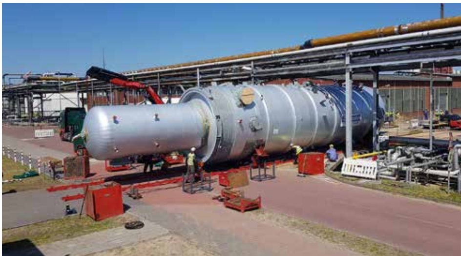
Verschubsysteme für das Platzieren der Last vor Ort gehören ebenfalls zum Equipment des Komplettanbieters im Bereich Schwerlastmontage.
