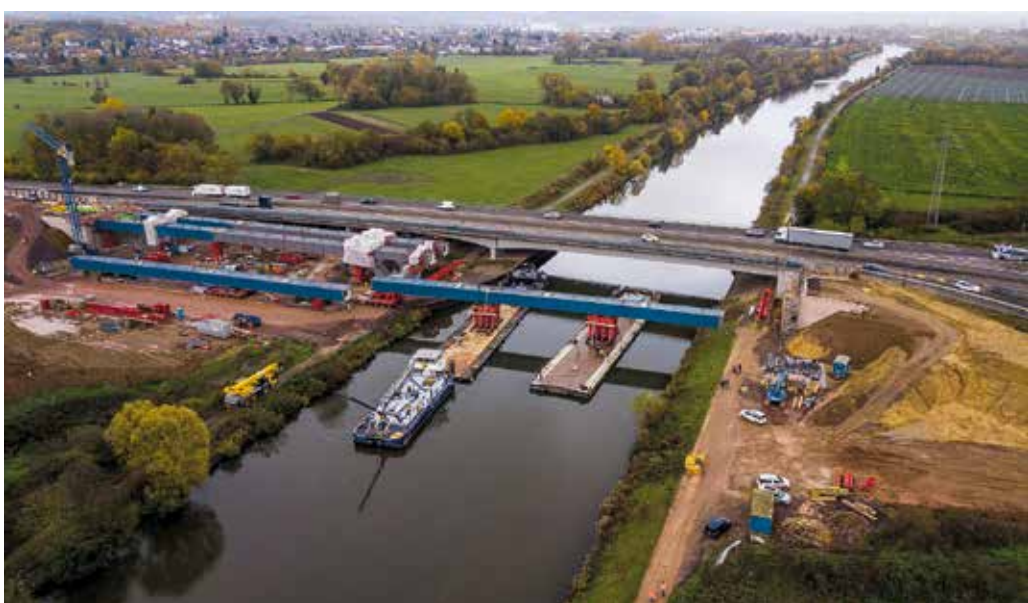
Zählt auch zu den Geschäftsfeldern: eine Brückeneinbringung auf dem Wasser mit einem Ponton.
