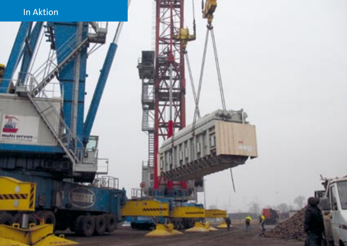
▲▼ Umschlag in Italien, direkt vom Schiff in das Schienen-Hochträgersystem.
