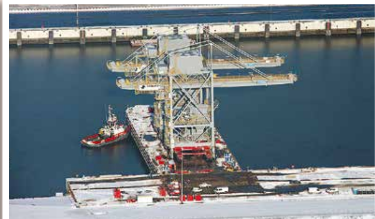
Weil in Eemshaven aufgrund des Tidenhubs die Verwendung eines Skid-Systems nicht möglich ist, erfolgte dort die Entladung im Ro-Ro-Verfahren mittels Selbstfahrern und unter Ausnutzung der Gezeiten.
