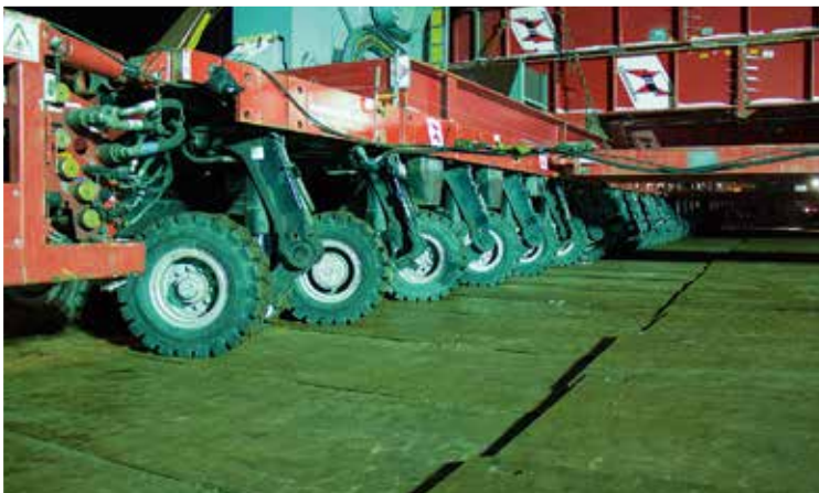
Nachdem Sand aufgeschüttet worden war, konnte eine temporäre Behelfsstraße eingerichtet werden.
