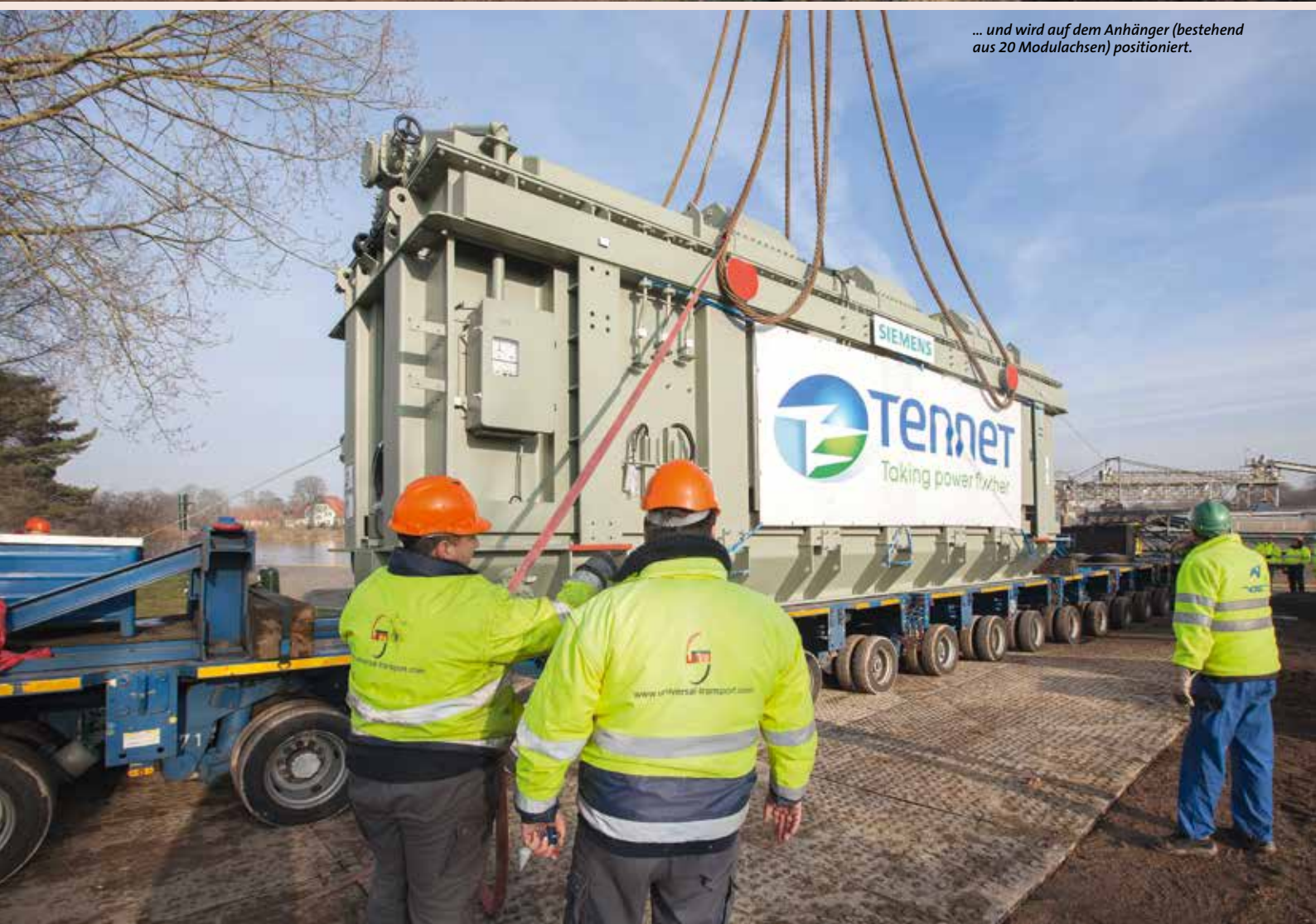
Im Hafen wurden entsprechende Transportkombinationen zur Beladung in Position gebracht.
