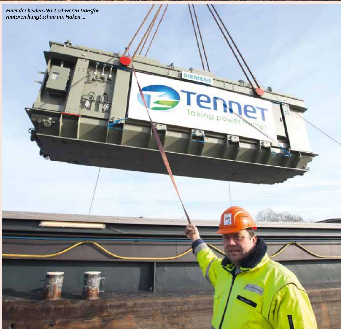
Ein Raupenkran übernahm auch im Umspannwerk den Umschlag der Transformatoren.
