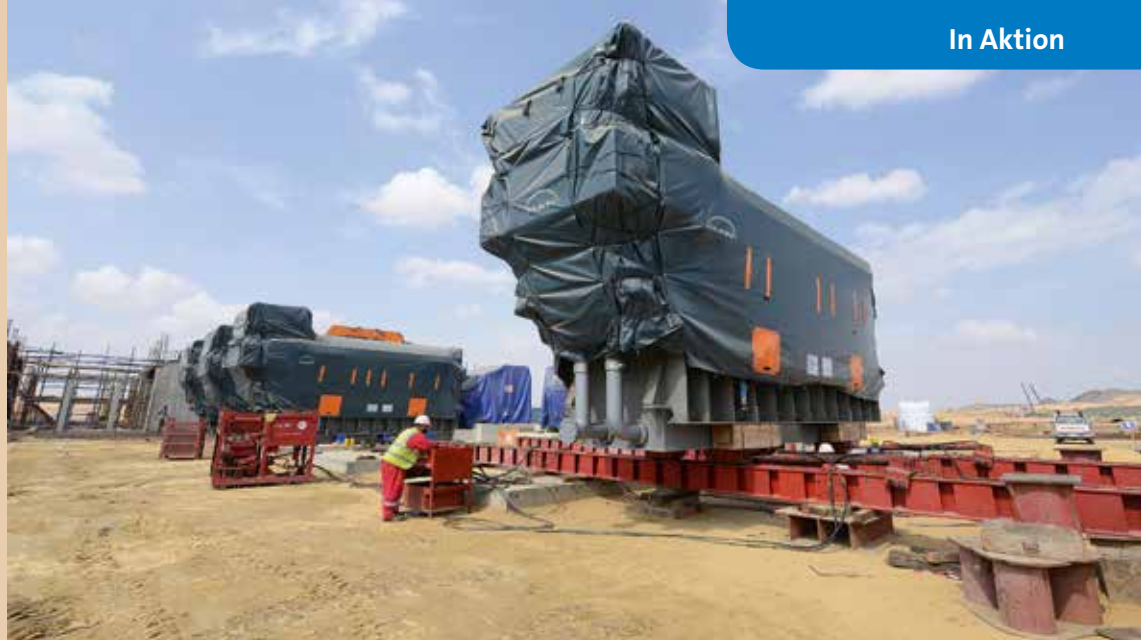
Perfektes Timing: die Schwertransporte erreichten die Baustelle genau zur richtigen Zeit.
