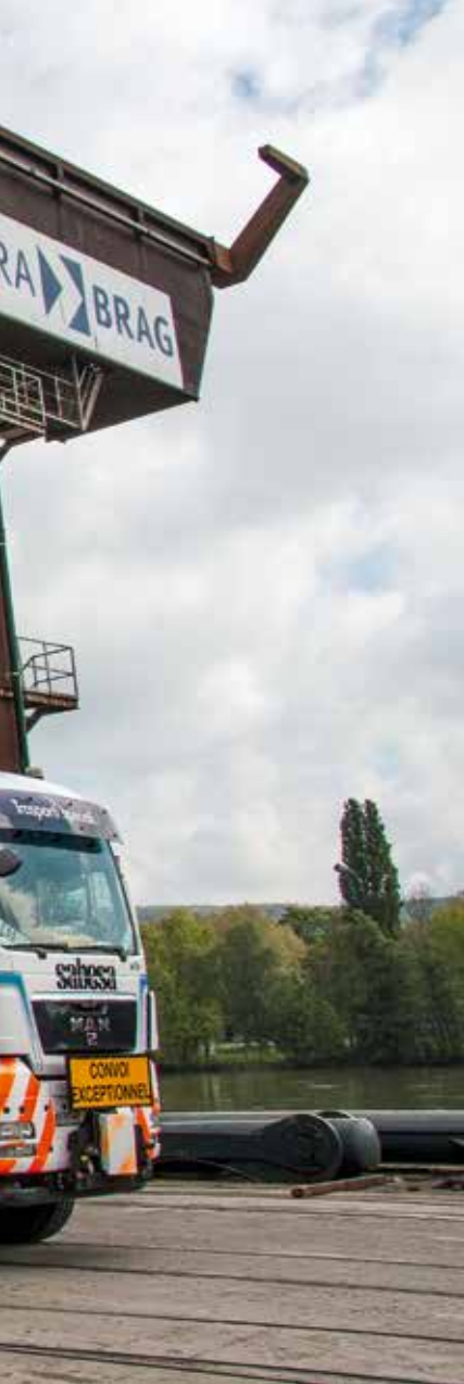
Mit Kran und Traverse wird das Hausboot auf dem Tieflader positioniert.
