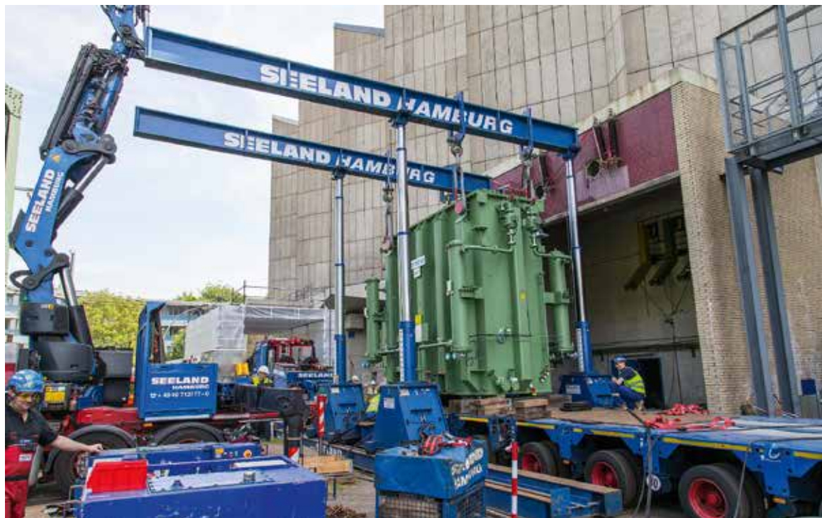
Die zu transportierenden Transformatoren brachten es auf Gewichte von 105 und 40 t.
