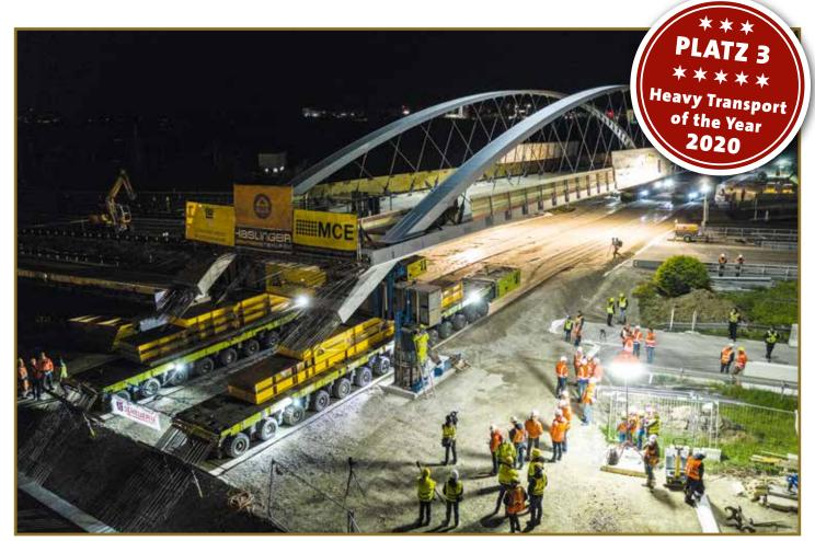
Den 3. Platz erreicht Schmidbauer mit dem schwersten Transport der Firmengeschichte. Transportiert wird die Streitgrabenbrücke über die A8. Die 1.600 t schwere und 130 m lange Brücke wird auf Scheuerle SPMT und mithilfe von insgesamt 50 Mitarbeitern mehrerer Gewerke über die Autobahn geschoben. Insgesamt 2.000 t bringt die Transportkombination dabei auf die Waage.
